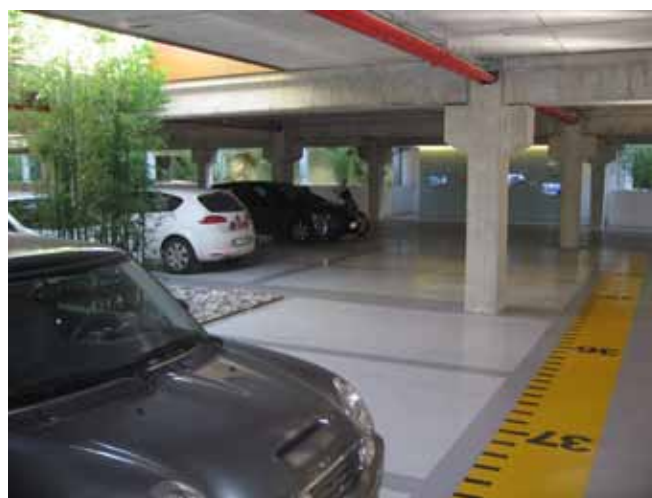
L'APARCAMENT ES VA RESOLDRE AMB UN ACABAT REMOLINAT MECÀNIC I UN TRACTAMENT DE PINTURA EPOXÍDICA AMB GRAFISMES PER LA NUMERACIÓ DE LES PLACES
