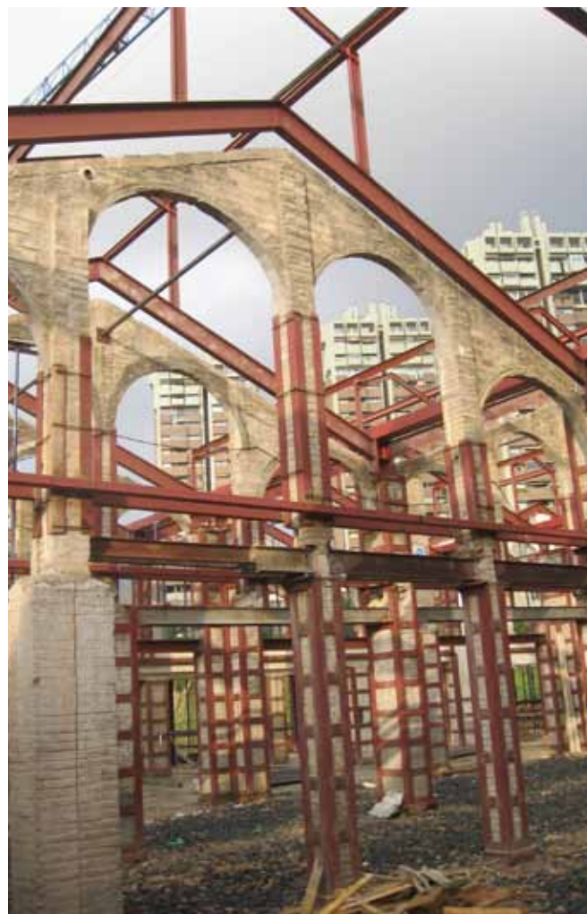
ESTRUCTURA DE LES NAUS
