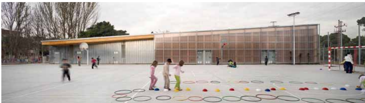
GIMNÀS EL BOSCH, A BARBERÀ DEL VALLÈS, AMB L'APLICACIÓ DE SISTEMES PREFABRICATS QUE INCIDEIXEN EN EL CONSUM ENERGÈTIC DE L'EDIFICI
