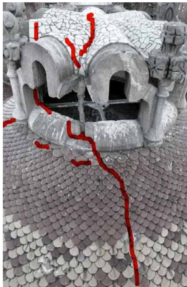
FIGURA 4. RESSEGUIMENT DE LES FISURES APCIADAS A LA COBERTA DE LA CÚPULA I A L'ELEMENT DE LA LLANTERNA
