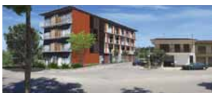
EDIFICACIÓ DE 30 HABITATGES DE PROTECCIÓ OFICIAL A BANYOLES AMB EL REVOLUCIONARI SISTEMA PATENTAT PER COMPACT HABIT
