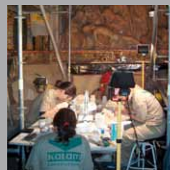
Restauració patrimoni Catedral de Santiago
