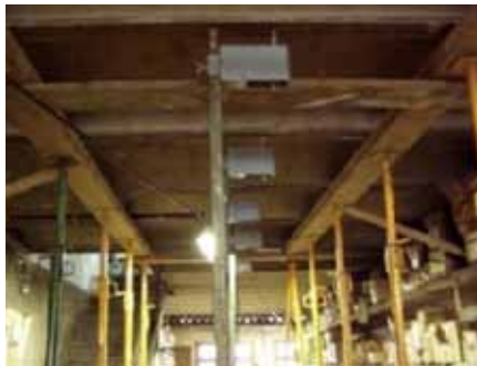
PER DETERMINAR LA SEGURETAT D'UN SOSTRE DE BIGUETES, SOVINT CAL PROCEDIR A VALORAR-LO EN CONJUNT, MITJANÇANT MODELS D'ANÀLISI MÉS O MENYS AJUSTATS, O A PARTIR DE PROVES DETERMINISTES ADAPTDES A CADA CAS. FONT: LABORATORI DE MATERIALS, EPSEB
