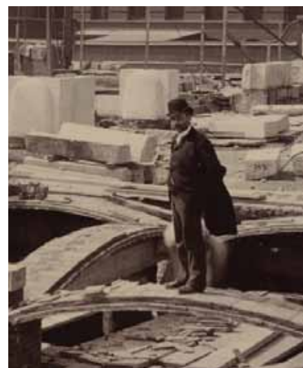
RAFAEL GUASTAVINO S'ESTÀ SOBRE UN ARC DE RAJOLA QUE S'ESTÀ CONSTRUÏT EN L'EDIFICI MCKIM AL CARRER BOYLSTON DE BOSTON. FOTO BOSTON PUBLIC LIBRARY
