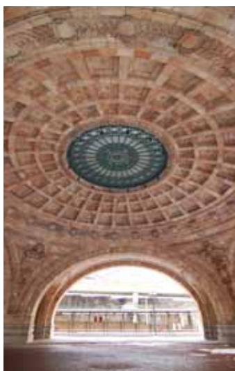
TERMINAL ORIGINAL DEL SUD DE LA PRIMERA LÍNIA DE METRO DE LA CIUTAT DE NOVA YORK, CONSTRUÏT EL 1904
