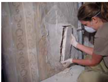
FISSURES I ESQUERDES EN DECORACIONS. ARRANCADA I ENGANXAMENT DE FRAGMENTS
