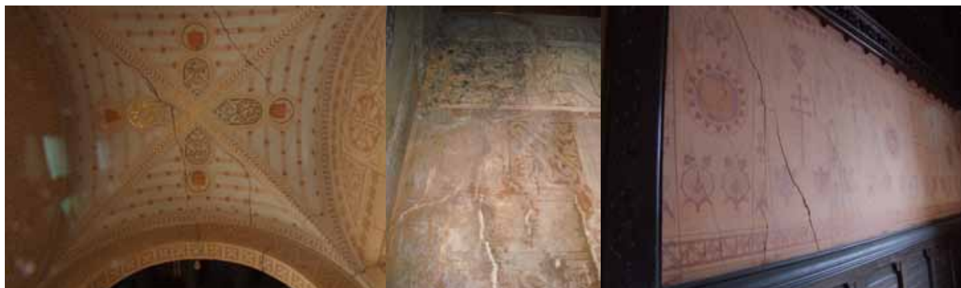
ESQUERDES EN VOLTES DEL NÀRTEX I EN PARAMENTS DEL VESTÍBUL
