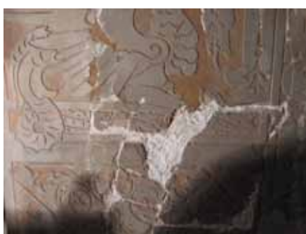
SEGELLAT D'ESQUERDES I FISSURES
