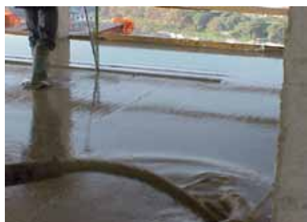
APLICACIÓ DEL MORTER AUTOANIVELLANT
