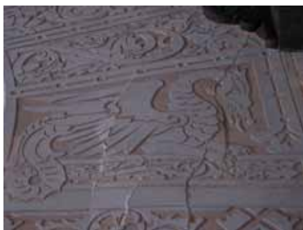
FISSURES I ESQUERDES EN DECORACIONS. ARRANCADA I ENGANXAMENT DE FRAGMENTS
