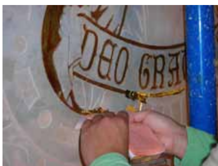
RESTAURACIÓ DE DAURATS EN DECORACIONS DEL VESTÍBUL
