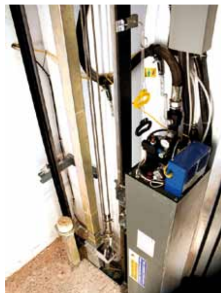
INSTAL·LACIÓ MRL (SENSE SALA DE MÀQUINES)
