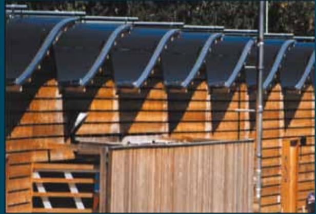
Piscina Municipal ILANZ (CH) - 453 m 2
