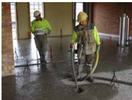
APLICACIÓ DEL MORTER AUTOANIVELLANT AÏLLANT ACÚSTIC
