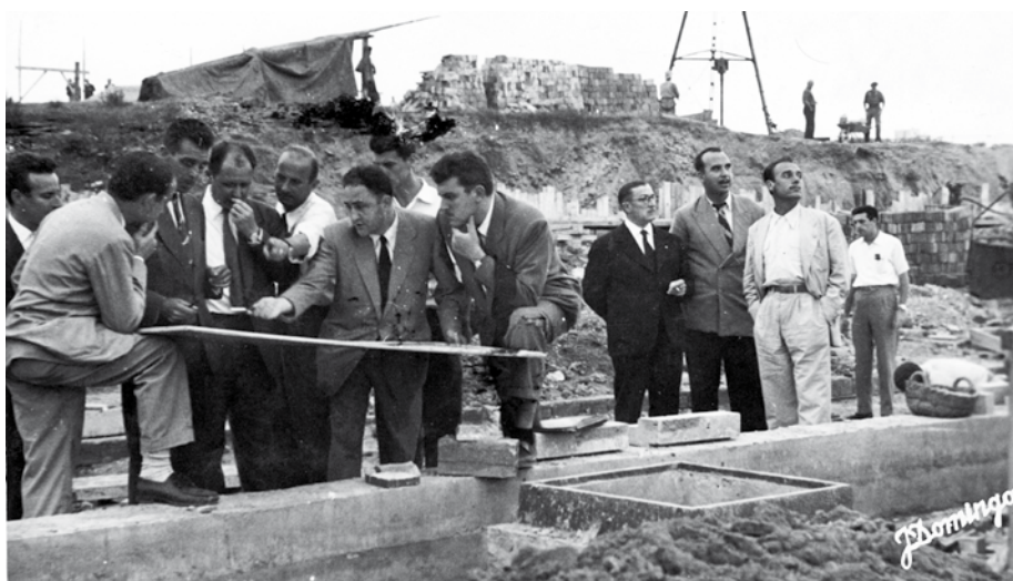
JAUME SALA EN VISITA D'OBRA DE FONAMENTS DEL CAMP NOU. 1954
