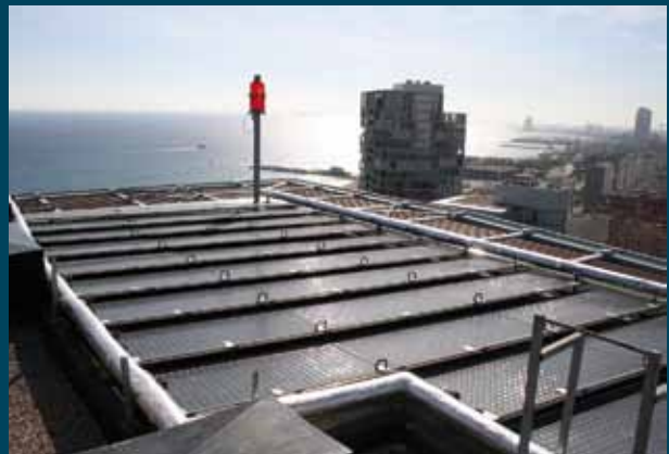
248 Viviendas Illa del Mar BARCELONA - 500 m 2
