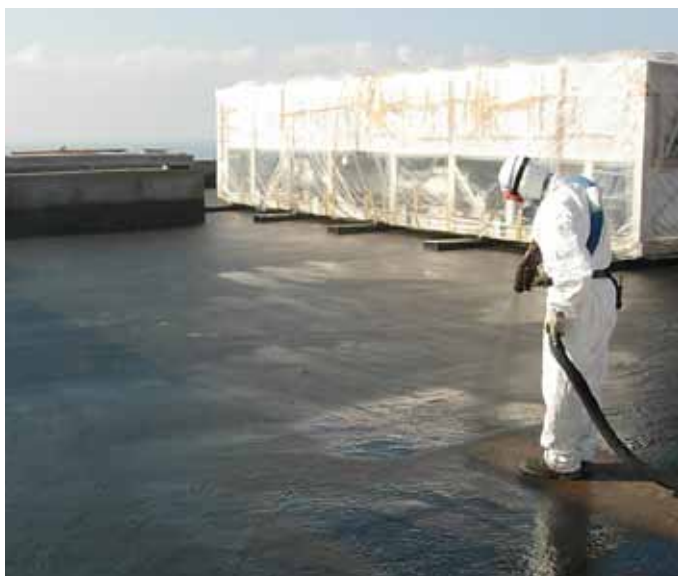
APLICACIÓ D'UNA MEMBRANA IMPERMEABLE. FONT: ARTLUX EUROPA SL
