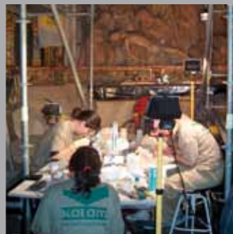
Restauració patrimoni Catedral de Santiago
