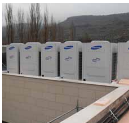
FIGURA 3. EXEMPLE D'INSTAL·LACIÓ D'UN SISTEMA CVR
