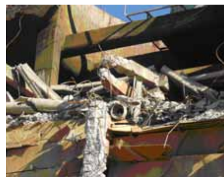
PLAQUES PLANES DE FIBROCIMENT A L'INTERIOR D'UNES TORRES DE REFRIGERACIÓ, TROBADAES UN COP COMENÇATS ELS TREBALLS D'ENDERROC. LES PLAQUES VAN SER TRENCADES, AMB LA CONSEQÜENT CONTAMINACIÓ AMBIENTAL, A CAUSA DE NO HAVER FET PRÈVIAMENT L'ESTUDI D'IDENTIFICACIÓ DELS MATERIALS AMB AMIANT
