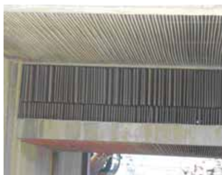
PLAQUES PLANES DE FIBROCIMENT A L'INTERIOR D'UNES TORRES DE REFRIGERACIÓ, TROBADAES UN COP COMENÇATS ELS TREBALLS D'ENDERROC. LES PLAQUES VAN SER TRENCADES, AMB LA CONSEQÜENT CONTAMINACIÓ AMBIENTAL, A CAUSA DE NO HAVER FET PRÈVIAMENT L'ESTUDI D'IDENTIFICACIÓ DELS MATERIALS AMB AMIANT
