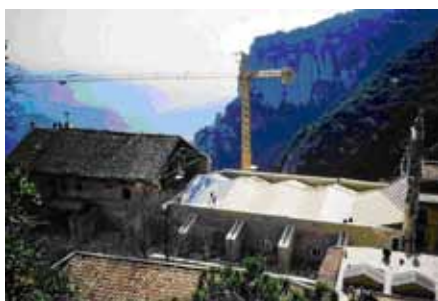
ABANS I DESPRÉS DE LES OBRES DE RECONSTRUCCIÓ DE LA COBERTA (1994). S'APRECIEIEN ELS CONTRAFORTS, ÒCULS I CIMBORIS RESCATATS
