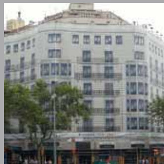
Restauració façana Pg de Gràcia Edifici Zurich Barcelona
