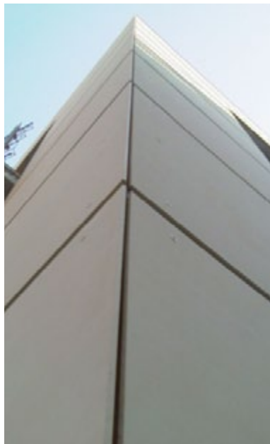
DETALL ESTRUCTURA TECCON I ACABAT AMB FAÇANA VENTILADA
