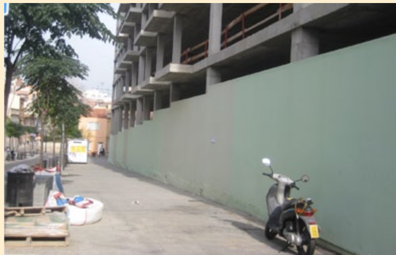
LA TANCA S'HA TRASLLADAT AL PLA DE FAÇANA EN UNA OBRA BEN ATURADA
