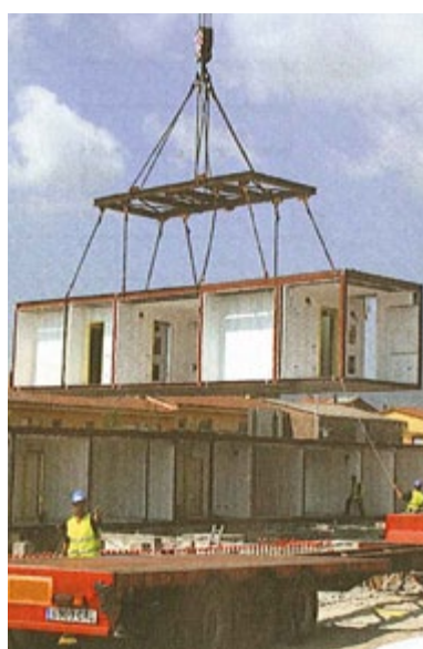
HABITATGES A TORELLÓ FABRICATS PER MODULTEC
