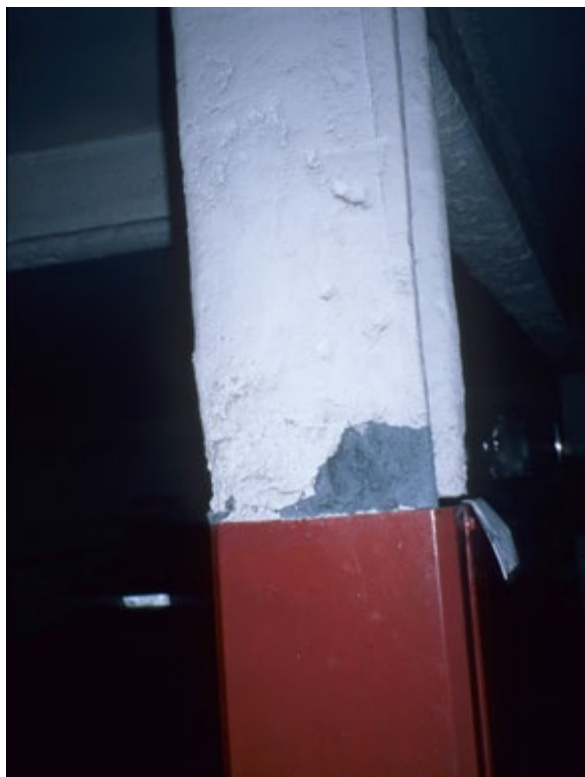
IGNIFUGACIÓ D'ESTRUCTURA
