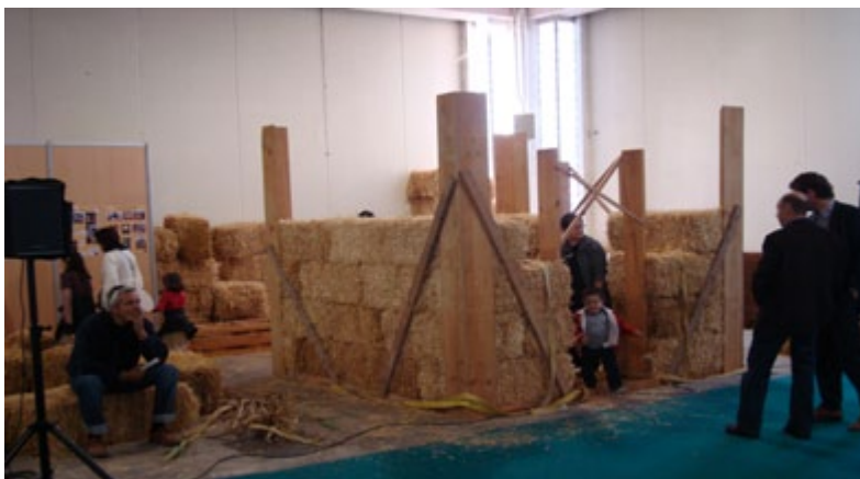
UN EQUIP DE 8 CONSTRUCTORS LIDERATS PER MAREN TÉRMENS VA AIXECAR UNA CASA DE BALES DE PALLA A LA FIRA ECOVIURE
