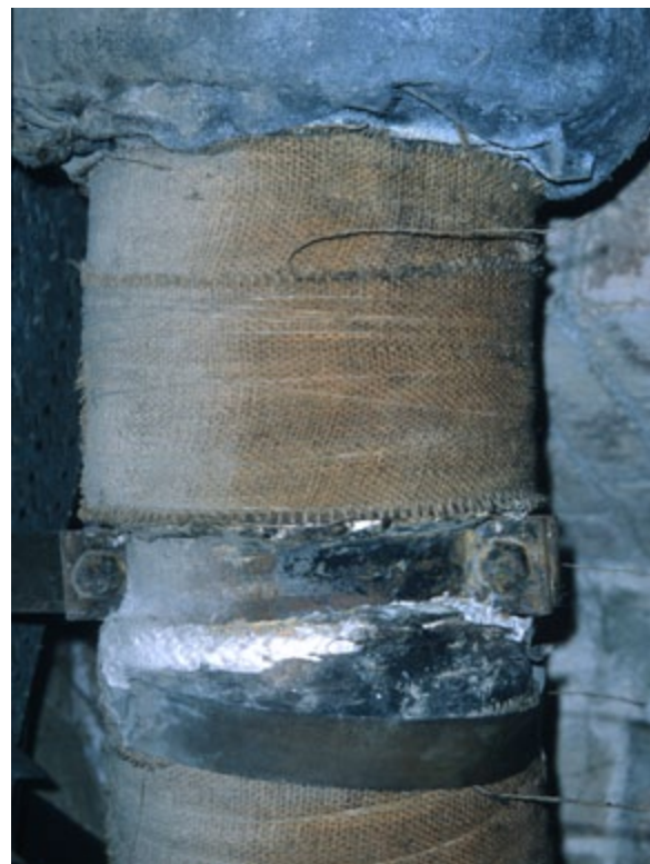
CALORIFUGACIÓ DE CANONADES
