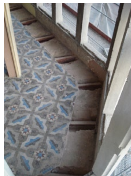
FASE FINALITZADA DE SANEJAMENT DE CAPS DE BIGA DE FERRO DE LLOSA DE TRIBUNES A FINCA DE L'EIXAMPLE, EN L'ESTAT PREVI A LA VISITA D'OBRA PER VALIDAR EL REPICAT I AUTORITZAR A INICIAR LA FASE DE PASSIVAT O OXISATURACIÓ DE LES BIGUES. OBRA AL CARRER BAILLEN, EXECUTADA PER TRAC L'ANY 2008
