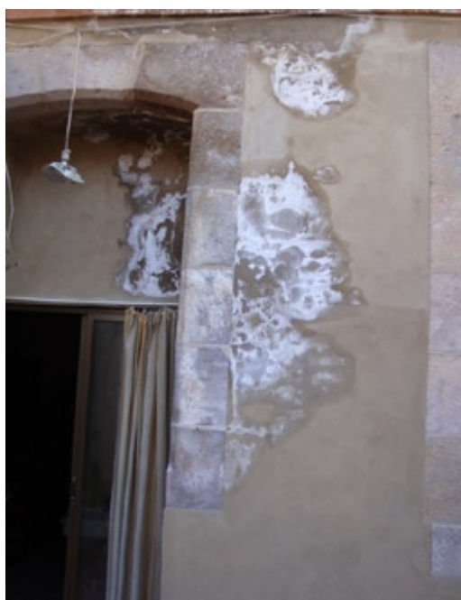
LES SALS QUE AFECTEN ALS ESTUCS HAN DE SER TRACTADES AMB "PAPETES" DE CEL·LULOSA I AIGUA DESTIL·LADA, RETORNANT EL PH ADEQUAT AL MATERIAL ABANS D'AUTORITZAR A LA SEVA REPARACIÓ O TRACTAMENT DE RESTAURACIÓ
