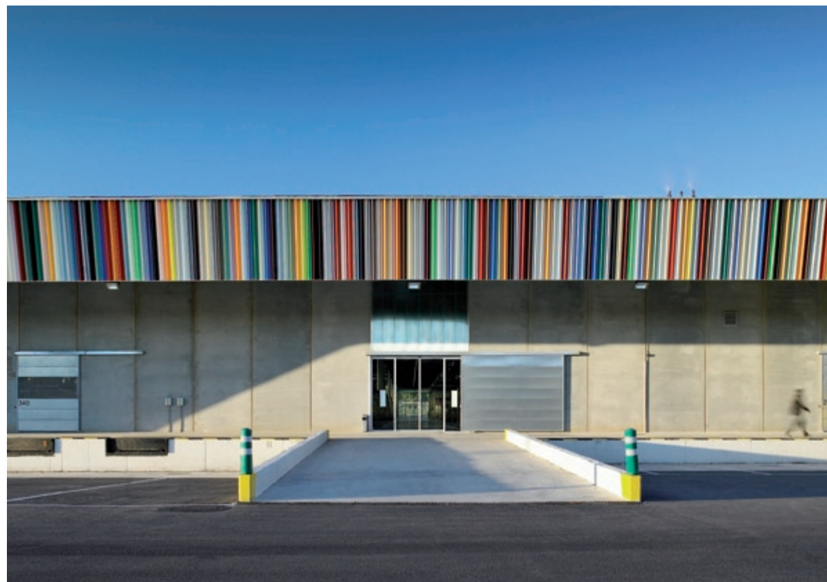
MOLLS DE CÀRREGA POSTERIORIS. LA SENEFA METÀL·LICA I PANNELLS PREFABRICATS RESOLEN EL TANCAMENT
