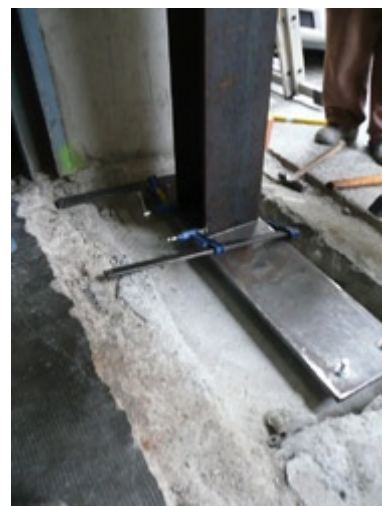
EN LES ACTUACIONS DE REFORÇ ESTRUCTURAL AMB ELEMENTS DE FERRO CAL TENIR ESPECIAL CURA A L'HORA DE VALIDAR LES SOLDADURES I, EN CAS DE DUBTE, DEMANAR LES PROVES ADIENTS DE CONFIRMACIÓ DE LA QUALITAT DE LES MATEIXES A UN LABORATORI QUE LES PUGUI CERTIFICAR. OBRA EN CURS A VIA LAITANA, EXECUTADA PER TRAC L'ANY 2009
