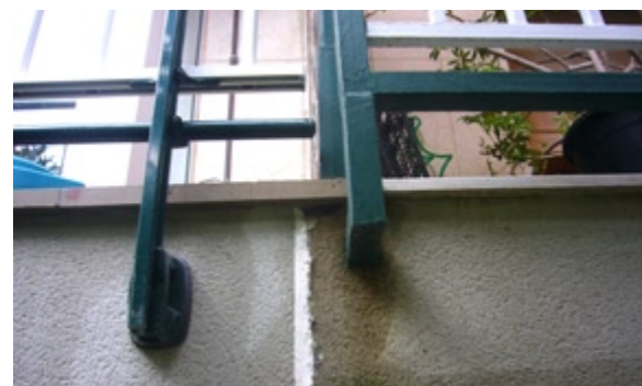
LA FIXACIÓ ESTANCA I ELS MATERIALS INOXIDABLES DE LA NOVA BARANA ASSEGUREN LA LONGEVITAT DELS FORJATS REPARATS
