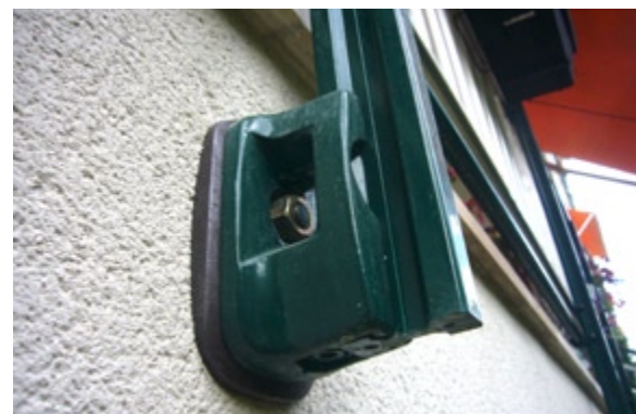
DETALL DE LA BASE D'ANCORATGE I EL PERFIL MASSÍS QUE FORMA EL MUNTANT DE LA BARANA. LA BASE PATENTADA DE 2 PECES I UN SOL CARGOL PERMET LA REGULACIÓ TRIDIMENSIONAL DEL MUNTANT
