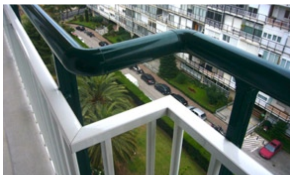
DETALL DE LA RECLADA DEL PASSAMÀ. ELS COLZES RESOLEN PERFECTAMENT LA CONTINUÏTAT DEL PASSAMÀ RODÓ
