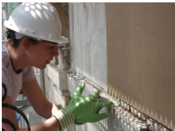
INJECCIÓ DE PLM A PLAQUES D'ESTUC PER TAL DE FIXAR-LES DE NOU AL SUPORT. LA DENSITAT DEL MATERIAL D'INJECCIÓ ESTÀ CALIBRADA A LES NECESSITATS DE CADA SITUACIÓ. OBRA AL CARRER CARME, EXECUTADA PER TRAC L'ANY 2008
