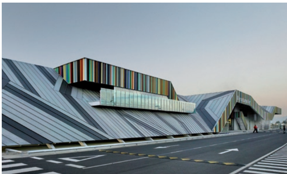
LA TERRASSA DEL BAR-RESTAURANT OBRE UN FORAT A LA COBERTA
