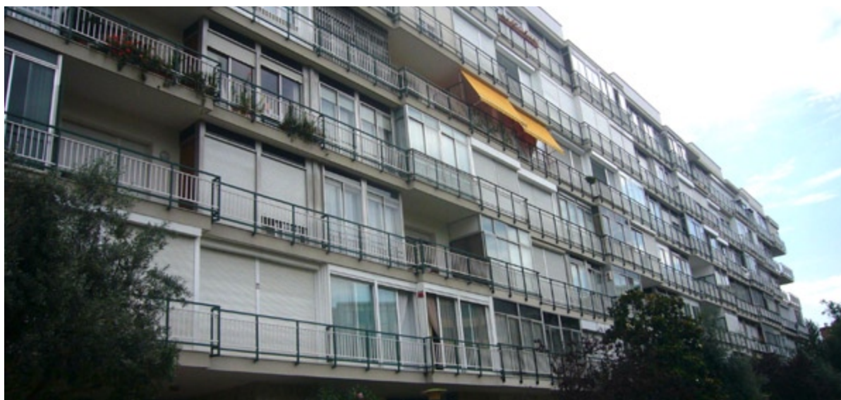
VISTA DE L'EDIFICI. EL SECTOR QUE HA ESTAT REHABILITAT ÉS EL CENTRAL I MANTÉ LA ESTÈTICA GENERAL MALGRAT LES OBLIGADES MODIFICACIONS
