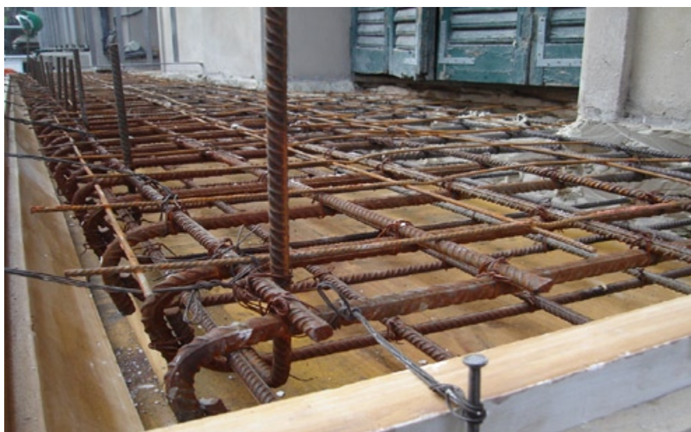
ESTRUCTURA PER A NOVA LLOSA DE FORMIGÓ ARMAT DE BALCÓ CORREGUT BALUSTRAT. MOMENT DE LA INSPECCIÓ DE LES ARMADURES I LA SEVA CORRECTA CONNEXIÓ AL SUPORT, PREVI A L'AUTORITZACIÓ DEL FORMIGONAT. FOTOGRAFIA DEL DOSSIER DE REGISTRE DE L'ACTA D'OBRA PERTINENT. OBRA AL CARRER NIL FABRA DE BARCELONA, EXECUTADA PER TRAC L'ANY 2009
