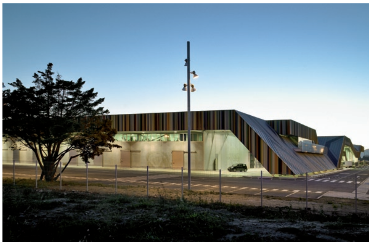
ÀREA D'APROVISIONAMENT DE LES CÀMERES DE FLOR TALLADA. A LA PART SUPERIOR S'AMAGUEN LES MÀQUINES DE REFRIGERACIÓ
