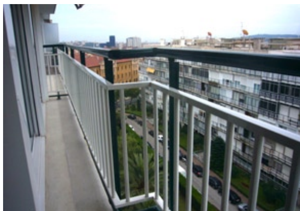
VISTA D'UN BALCÓ DES DE L'INTERIOR. LES TRAMADES DE BARROTS VENEN FABRICADES A MIDA
