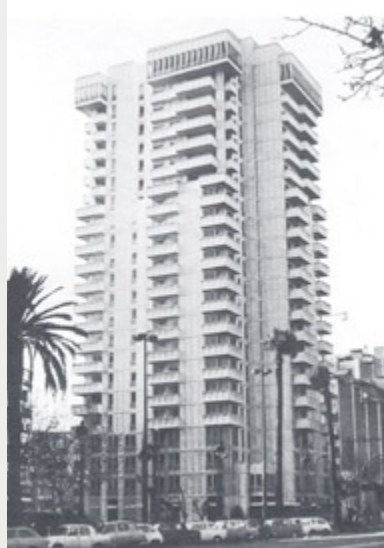
ARQUITECTURA Edifici Atalaya. Diagonal, 523. Barcelona. APARELLADORS: Jaume Espuga, José Moreno i José Castrillo i Joan Dalmau Carceller
