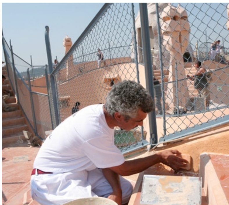
ESTUC DE CALÇ LLISCAT, MÈTODE TRADICIONAL A LA CASA MILÀ (LA PEDRERA)
