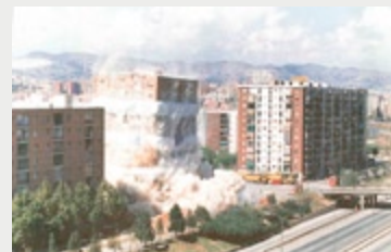
ENDERROC AMB VOLADURA CONTROLADA AL BARRI DE LA PAU DE BARCELONA
