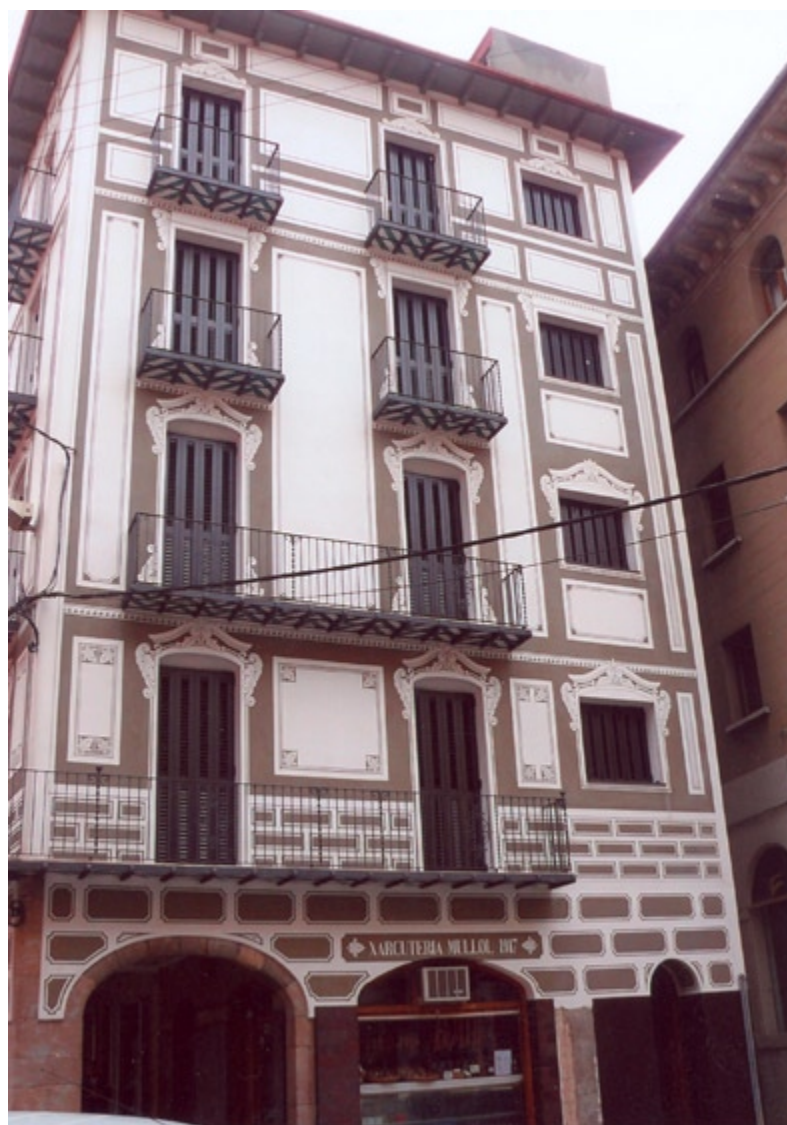
FAÇANA RESTAURADA ACABAT ESGRAFIADA SEGUINT L'ORIGINAL DE 1907
