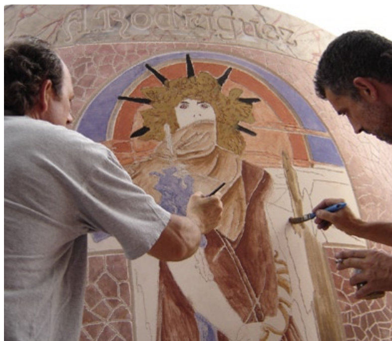
ESTUC DE CALÇ: ESGRAFIAT, PINTAT AL FRESC, IMITACIÓ DE MARBRE I TRENCADÍS
