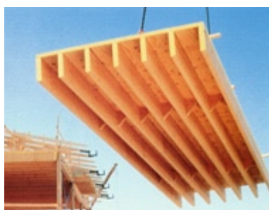
PLAFÓ PREFABRICAT DE FUSTA PER A SOSTRES FINNFOREST
