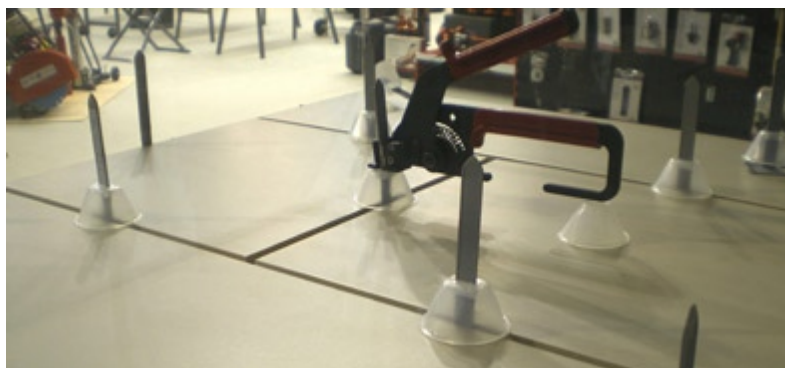
SISTEMA D'ANIVELLAMENT DE RAJOLE RUBI TILE LEVEL (GERMANS BOADA)
