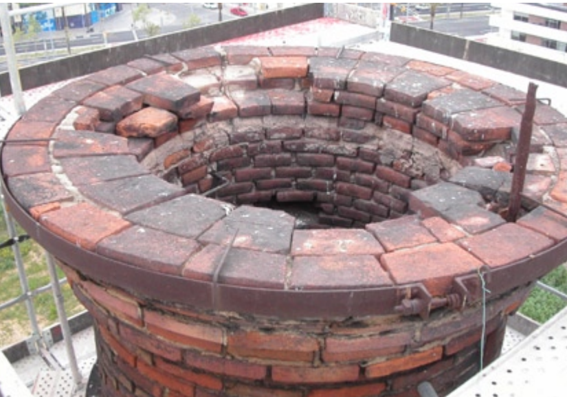
IMATGES DE L'ESTAT PREVI DE LA XEMENEIA HISTÒRICA DE CA L'ARANYÓ. FOTOS: PEP BRAZO
