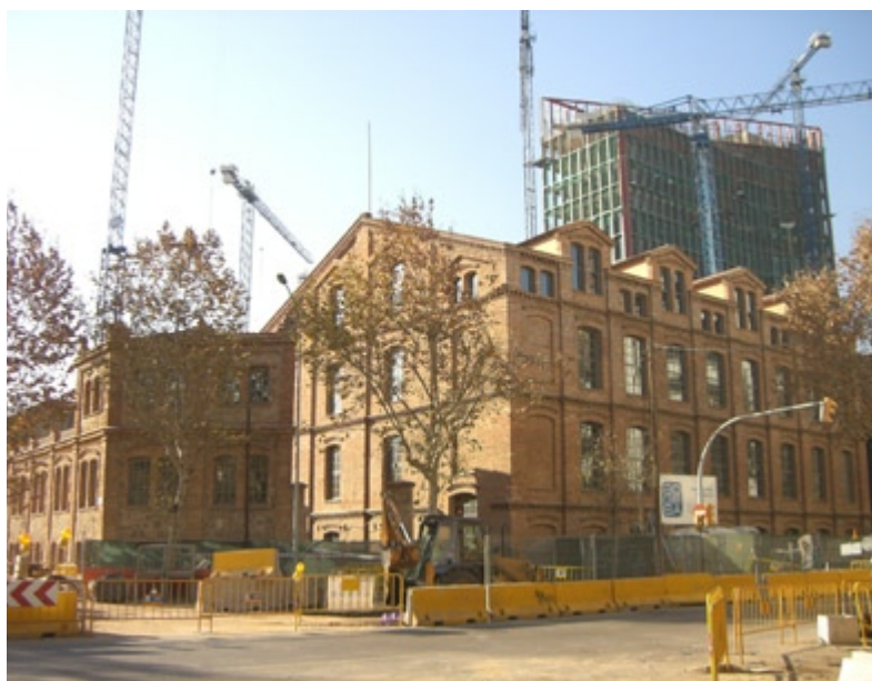
CA L'ARANYÓ EN OBRES
