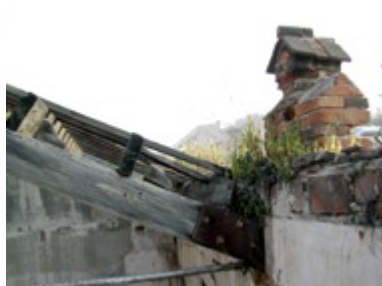
3. RECOLZAMENT AMB MERLET. FAÇANA PRINCIPAL
