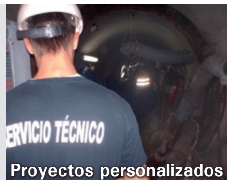
Ventilación forzada temporal
