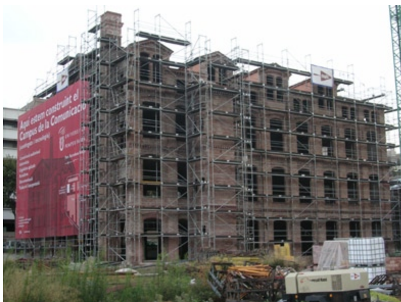
LA REHABILITACIÓ DEL CONJUNT INDUSTRIAL HA RESCATAT LA FÀBRICA DE L'ESTAT RUÏNÓS
