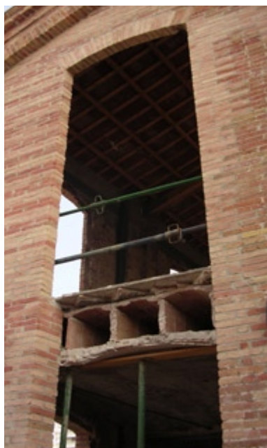
5. SECCIÓ DE LA VOLTA I ELS SEUS DIFERENTS GRUIXOS
