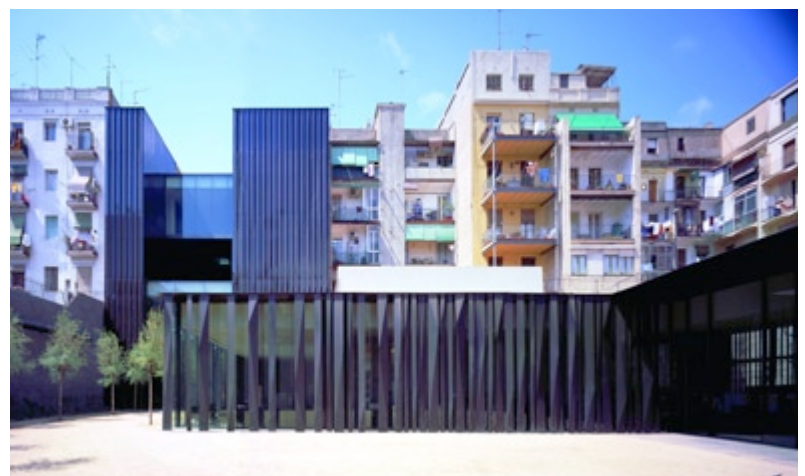
BIBLIOTECA, CENTRE PER A LA TERCERA EDAT I INTERIOR D'ILLA DEL DISTRICTE DE SANT ANTONI. (FOTO DE: HISAO SUZUKI)
