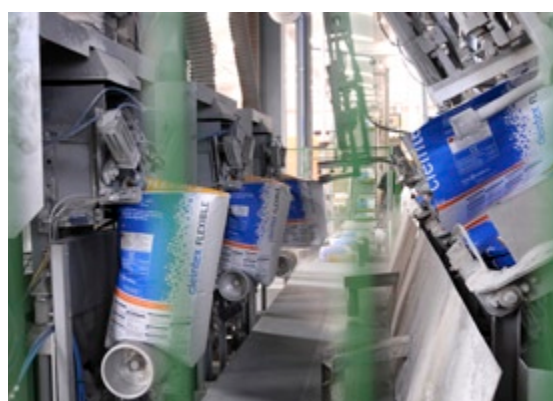
OPERACIÓ D'ENSACADA DEL MORTER
