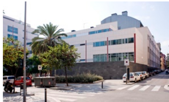
FAÇANA A CARRER DE L'EDIFICI REFORMAT
