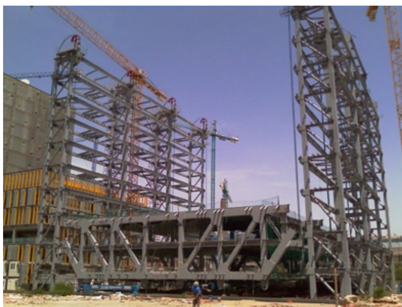
FIG. 2. MUNTATGE DE LA JÀSSERA DE SUPORT
