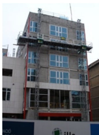
EDIFICI PROTEGIT DES DEL CARRER. PROCÉS DE COL·LOCACIÓ DE LA PEDRA DE LA FAÇANA VENTILADA
