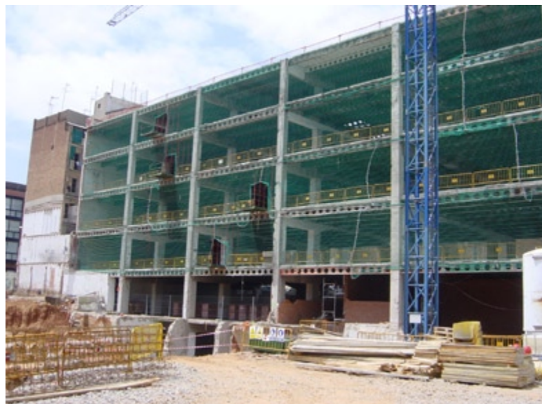
EDIFICI REMODELAT UN COP ACABAT L'ENDERROC DE FAÇANES I PARTONS
