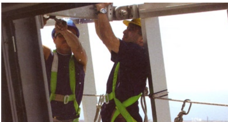
TREBALLS EN ALÇADA. FOTO CEDIDA PER LA FUNDACIÓ LABORAL DE LA CONSTRUCCIÓ
