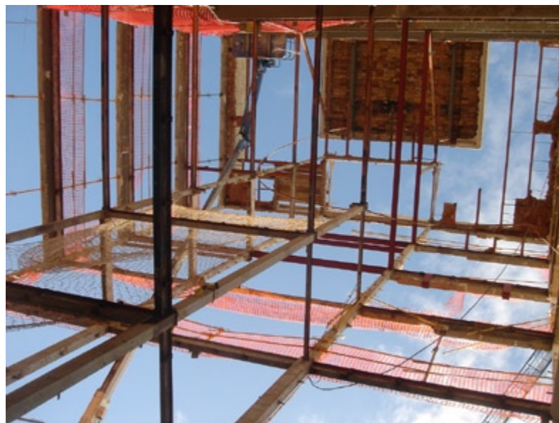
TASQUES D'ENDERROC DE FORJATS I TANCAMENT, CONSERVANT L'ESTRUCTURA
