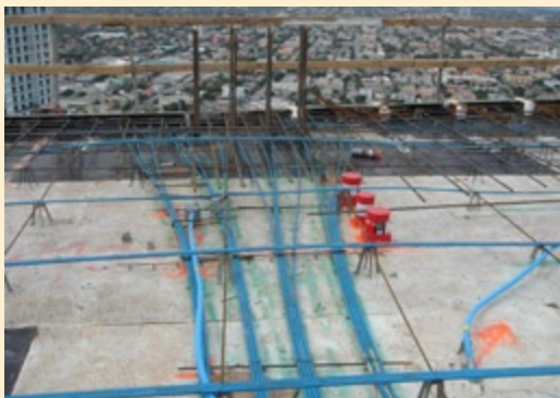
DETALLS CONSTRUCCIÓ DE LLOSA POSTTESADA
