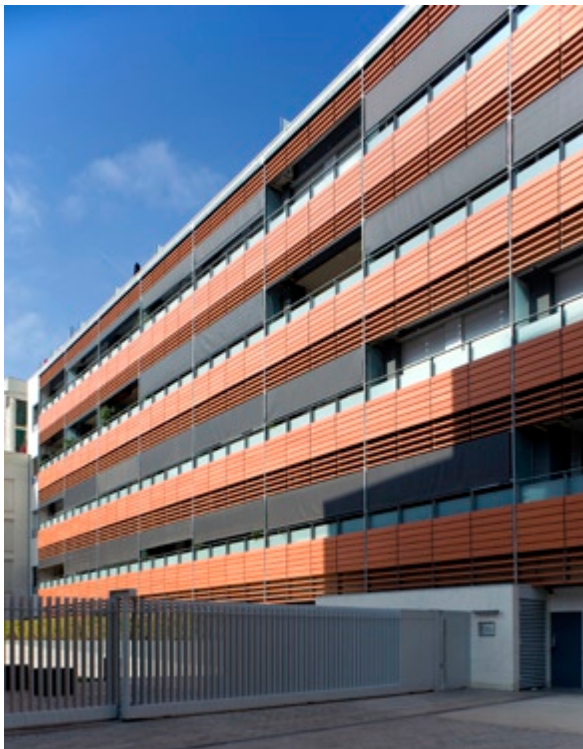
FAÇANA SUD-EST EDIFICI REFORMAT
