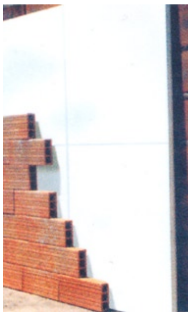
LA PLACA CYPSPOR PRESENTA UN DISSENY AMB UNA SUPERFÍCIE GOFRADA QUE OPTIMITZA L'ADHERÈNCIA I L'ESTABILITAT D'ARREBOSSATS I ESTUCATS
