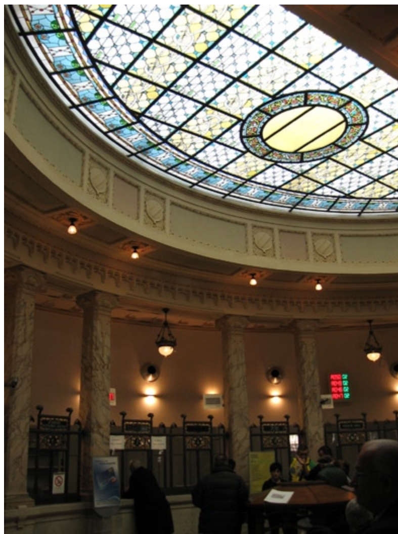
DETALL DE L'INTERIOR DE L'EDIFICI DE CORREUS
