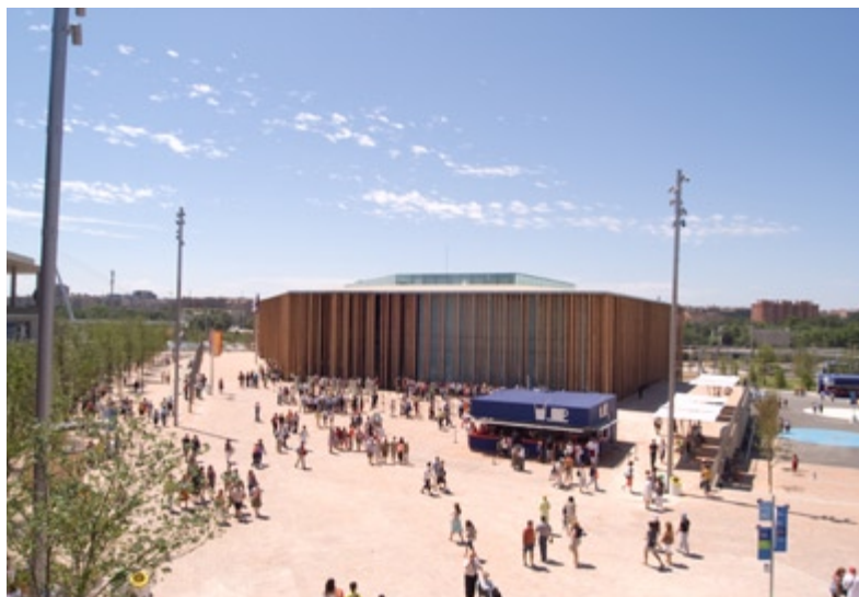
TREBALLS D'IMPERMEABILITZACIÓ EN EL PAVELLÓ D'ESPANYA
