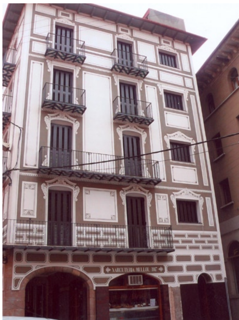
FAÇANA RESTAURADA ACABAT ESGRAFIADA SEGUINT L'ORIGINAL DE 1907
