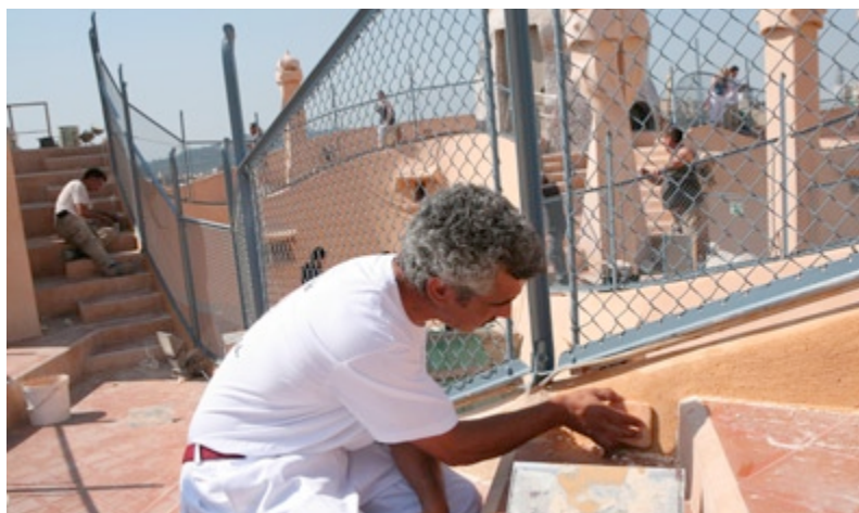
ESTUC DE CALÇ LLISCAT, MÈTODE TRADICIONAL. EDIFICI LA PEDRERA, CASA MILÀ
