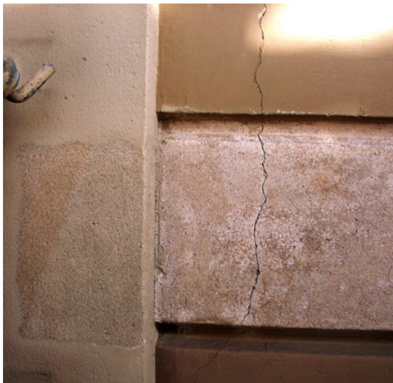
ELIMINACIÓ DE PINTURES SOBRE MUNTANT DE PEDRA (ESQUERRA) I ARREBOSSAT (DRETA)
