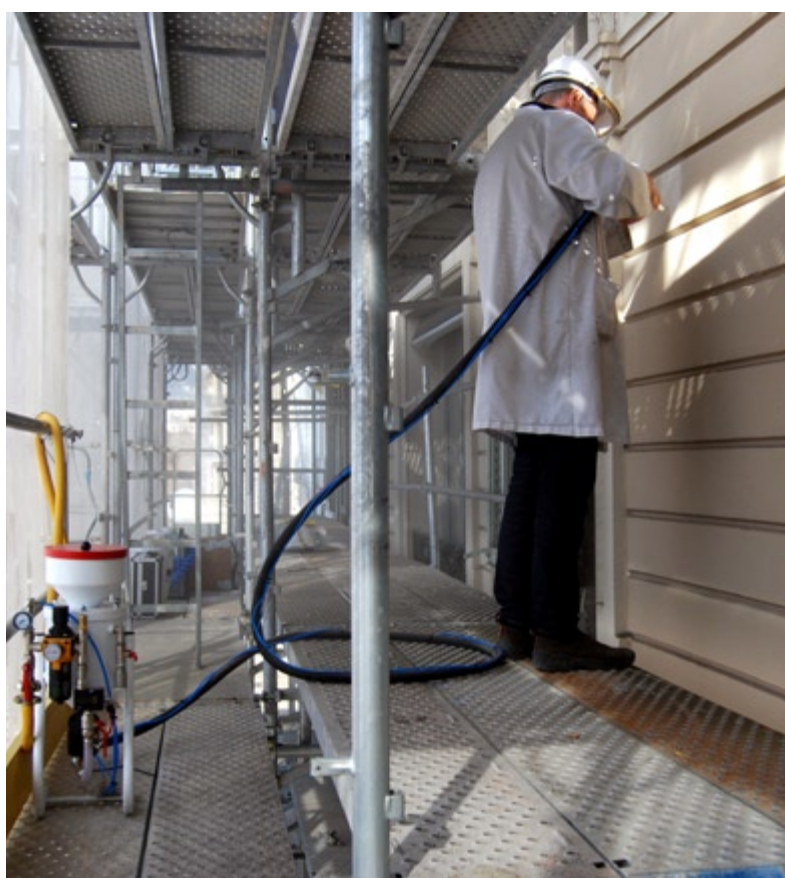
DIFERENTS PROVES D'ELIMINACIÓ DE PINTURES SOBRE ARREBOSSAT
