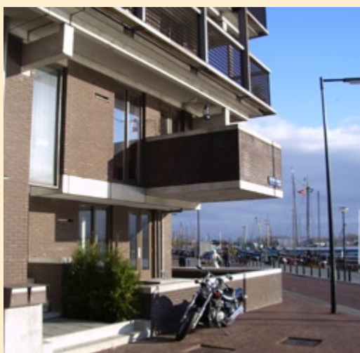
IMATGE 1. EDIFICI SITUAT AL PORT D'AMSTERDAM
