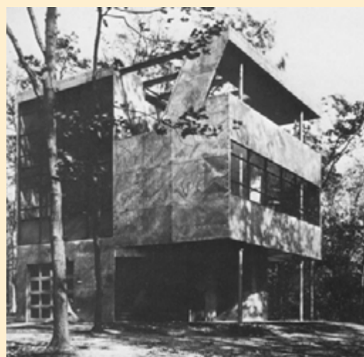
IMATGE 2. CASA ALUMINAGE
