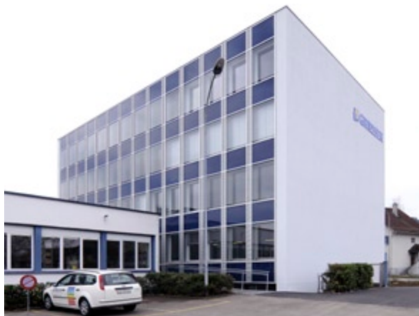
VISTA GENERAL DE LA FAÇANA EST
