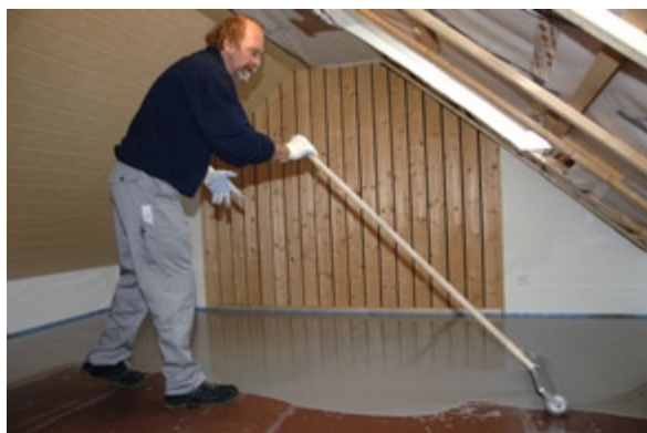
LA FACILITAT I RAPIDESA D'APLICACIÓ DE PCI NANOSILENT EL FA UN PRODUCTE IDEAL PER A LA REHABILITACIÓ DE FORJATS QUE NO CUMPLEIXIN AMB LA NOVA NORMATIVA REFERENT A AÏLLAMENT ACÚSTIC A IMPACTE.
