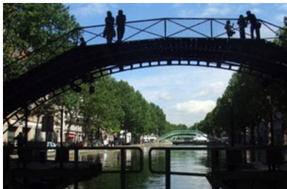
CANAL SAINT MARTIN, PASSANT UNA RESCLOSA
