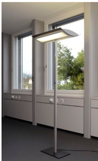
UNA DE LES DUES LLUMINÀRIES QUE IL·LUMINEN CADA SALA, AMB ELS DETECTORS INCORPORATS AL SUPORT
