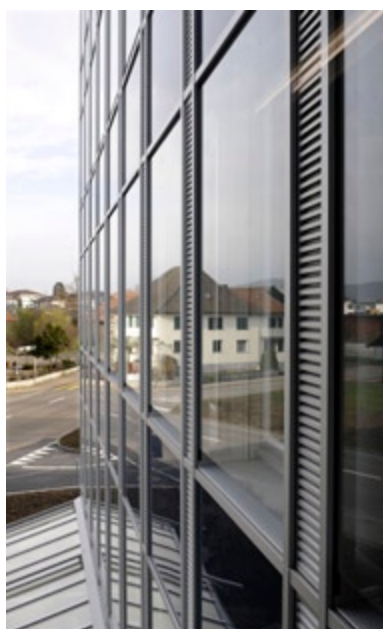
DETALL DE LA VENTILACIÓ DEL MUR CORTINA
