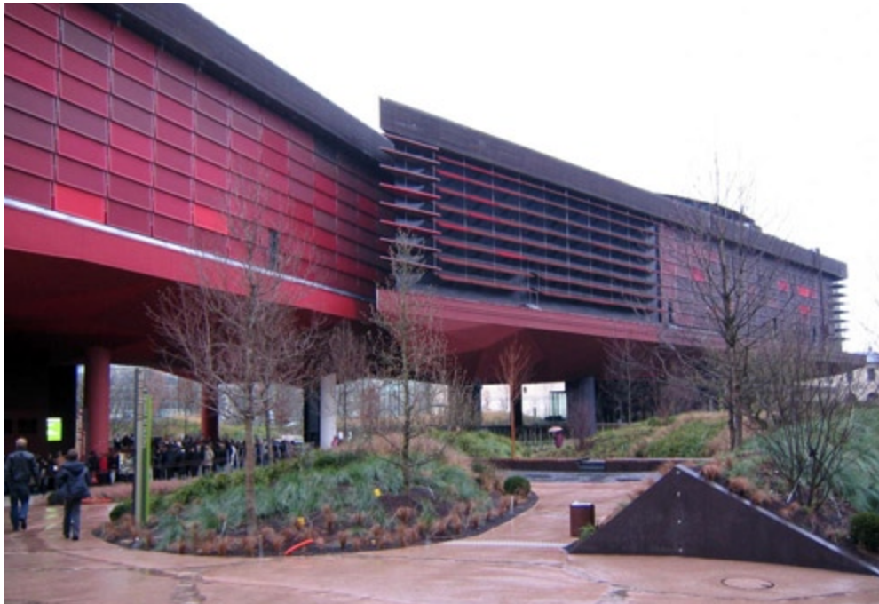
EDIFICI QUE ALBERGA LA MEDIATECA DEL MUSEU DU QUAI BRANLY
