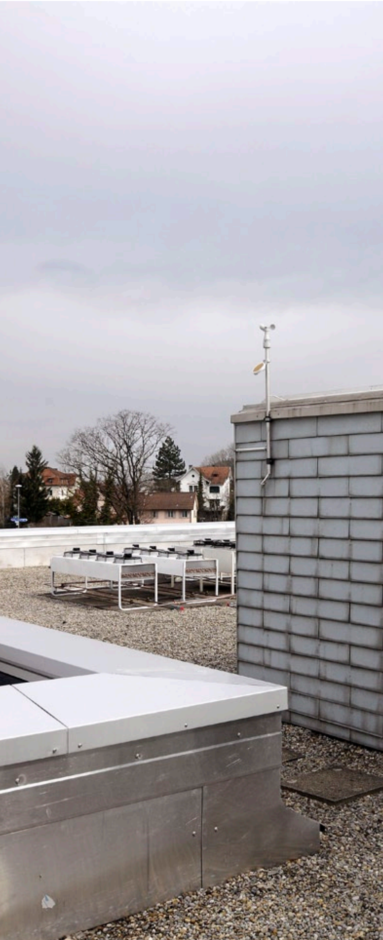
EN AQUESTA IMATGE DEL TERRAT S'APRECIA: - L'ACABAT DE FAÇANA AMB LA SOLUCIÓ DE CONTINUÏTAT ENTRE L'AÏLLAMENT DE COBERTA I EL DE FAÇANA, PER EVITAR PONTS TÈRMICS, SOTA LA XAPA DE CORONAMENT - LES UNITATS EXTERIORS DE CLIMATITZACIÓ, (OBSERVEU LA SEVA REDUÏDA MIDA) - EL SENSOR QUE DETECTA VENT, SOL, PLUJA I TEMPERATURA, INSTAL·LAT A LA PARET DEL BADALOT DE L'ESCALA
