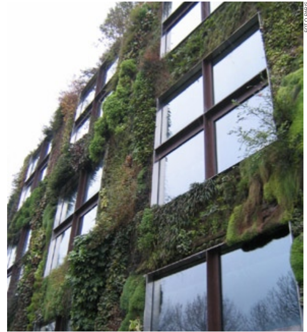
DETALL DE LA FAÇANA DE L'EDIFICI DESTINAT A SERVEIS ADMINISTRATIS DEL MUSEU DU QUAI BRANLY
