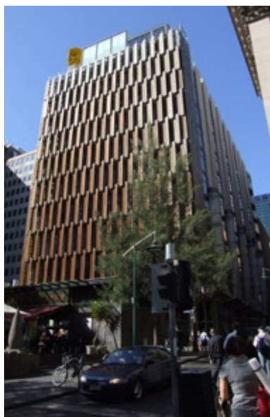
L'EDIFICI CH2, DE L'AJUNTAMENT DE MELBOURNE, VA SER UN DELS EXEMPLES MÉS SIGNIFICATIS I AGOSARATS QUE ES VA VEURE A LA CONFERÈNCIA. GRAN EFICIÈNCIA ENERGÈTICA, VENTILACIÓ CREUADA, SISTEMA DE REFRIGERACIÓ PASSIU I MOLTES ALTRES MILLORES TANT PER L'EFICIÈNCIA L'EDIFICI COM PEL CONFORT DELS SEUS USUARIS. TOT AIXÒ L'HA FET MEREIXEDOR DE 6 ESTELS, MÀXIMA AVALUACIÓ DEL GREEN BUILDING COUNCIL AUSTRALIA.
