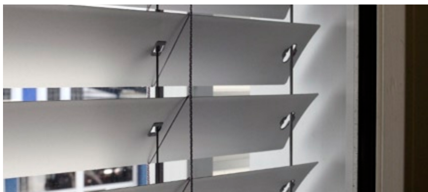
DETALL DE LES LAMEL·LES ALUFLEX DE LA FAÇANA EST
