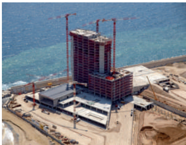
VISTA AÈREA ACTUAL DE LES OBRES DE L'HOTEL VELA
