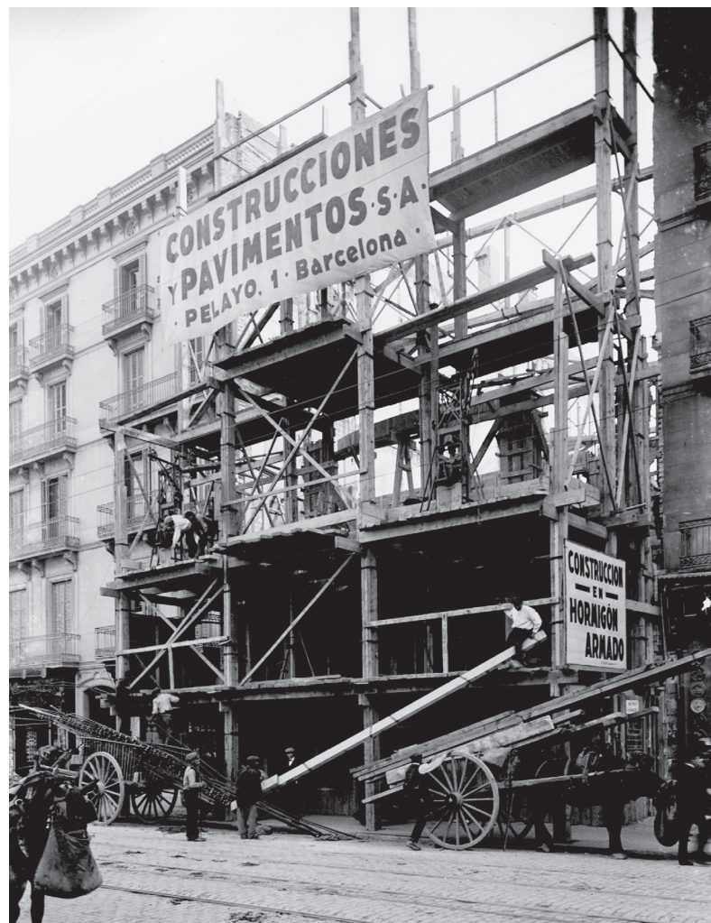
FIG. 7. EDIFICI DE FORMIGÓ ARMAT DE L'EMPRESA CONSTRUCCIONES Y PAVIMENTOS EXECUTAT ENTRE EL 1910 I 1920, EN QUÈ VA COL·LABORAR EDUARD FERRÉS. FOTO DE L'ARXIU NACIONAL DE CATALUNYA. FONS BRANGULÍ.
