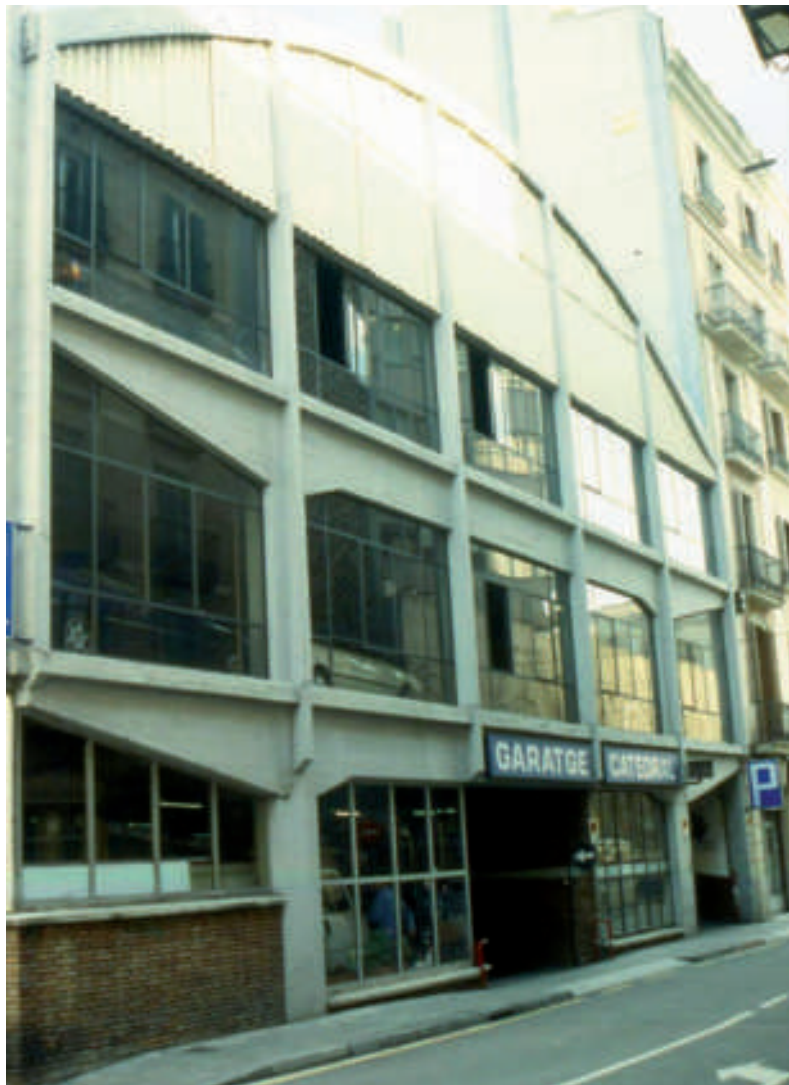
FIG. 9. GARATGE CATEDRAL, D'ANGLADA, GELABERT I RIBAS AMB TOTA LA SEVA EXPRESSIVITAT DELS ELEMENTS DE FORMIGÓ ARMAT, AMB VOLADISSOS DE FINS A TRES METRES (AVUI ENDERROCAT).
