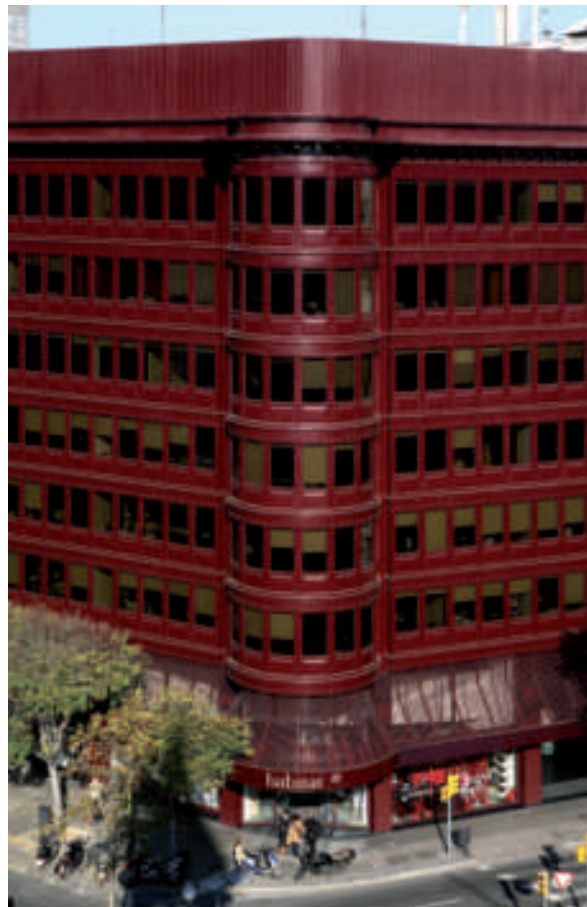
AVUI, L'EDIFICI TORNA A LLUIR EL SEU COLOR ORIGINAL
