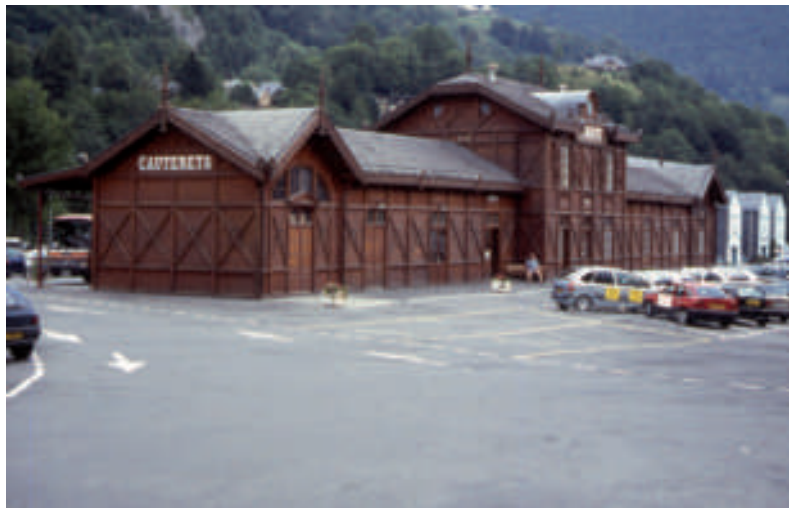
FIG. 1. VISTA GENERAL DE L'ESTACIÓ DE TREN AVUI REUTILITZADA COM A ESTACIÓ D'AUTOBUSOS
