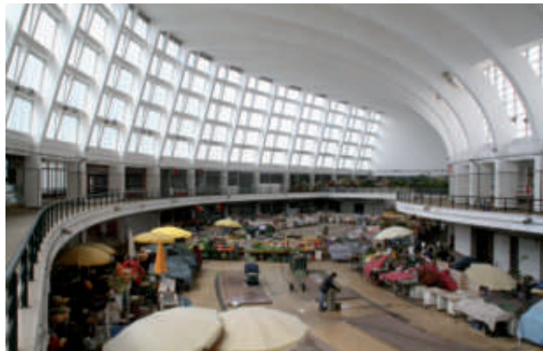
FIG. 11. EL FORMIGÓ DELS ANYS 60 I LA SEVA EXPRESSIVITAT. MERCAT MUNICIPAL D'OPORTO. ESTRUCTURA DE FORMIGÓ ARMAT D'ARCS PORTICATS. VISTA GENERAL INTERIOR
