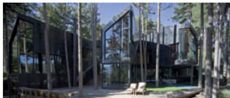
DETALL DE L'ORIGINAL COBERTA DE L'HABITATGE
