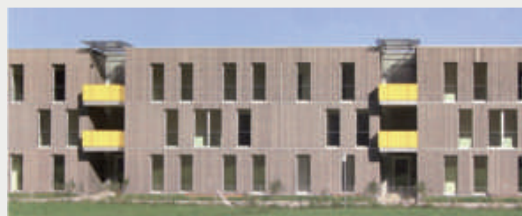
SAMER MÖSL, EDIFICI DE FUSTA, A SALZBURG
