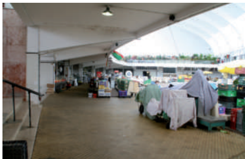
FIG. 10. MÈNSULES QUE SUPORTEN EL PASSADÍS INTERIOR PER ACCEDIR A LES PARADES SUPERIORS
