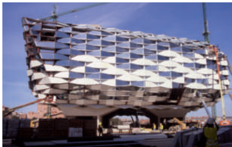
PAVEL·LÓ D'ARAGÓ, MENTRE FINALITZEN ELS TREBALLS DE COL·LOCACIÓ DELS PLAFONS DE TANCAMENT DE FAÇANA
