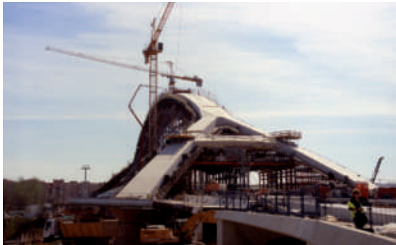
PONT DEL TERCER MIL·LENNI EN EL MOMENT D'ESTIRAR ELS CABLES METÀL·LICS DELS TENSORS
