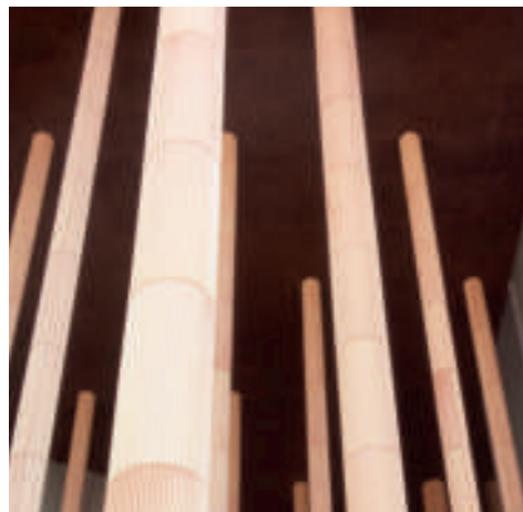
PAVEL·LÓ D'ESPANYA, DETALLS DEL "BOSC" DE COLUMNES CERÀMIQUES (REALITZADES PER ANTONI CUMELLA) PER ON BAIXARÀ L'AIGUA DES DE LA COBERTA PEL SEU INTERIOR
