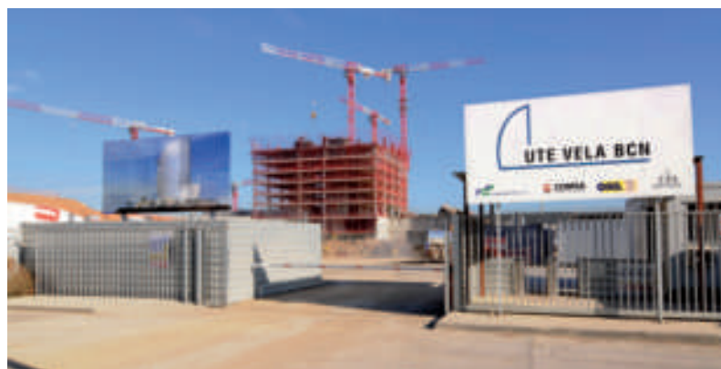
LA CONSTRUCCIÓ I EXPLOTACIÓ D'AQUESTS TERRENYS PORTUARIS VA A CÀRREC DE L'UTE NOVA BOCANA
