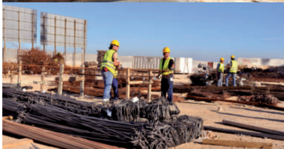
UNA IMPECABLE INFRAESTRUCTURA ORGANITZA ACURADAMENT ELS TEMES D'ORDRE, NETEJA, SEGURETAT... L'OBRA ACONSEGUEIX, EN AQUEST ASPECTE, UNA EFECTIVITAT MODÈLICA
