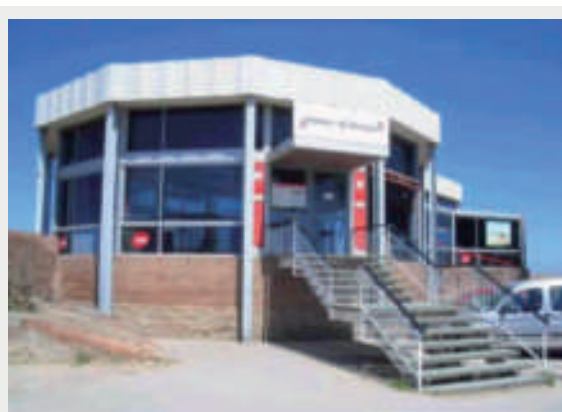
IMATGE EXTERIOR DE L'ANTIGA ESTACIÓ D'ARRIBADA AL CASTELL DE MONTJUÏC
