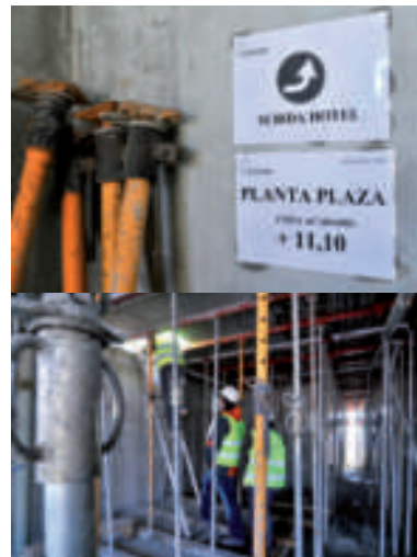
ELS PUNTALS PER A LES LLOSES ES COL·LOQUEN PER SEGURETAT, PERQUÈ NO CALEN
