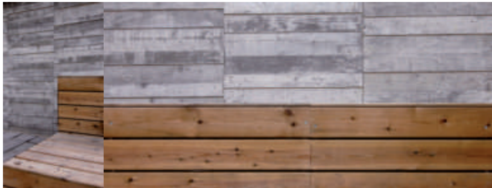
AMB SUPERFÍCIES NUES DE REVESTIMENT I GEOMETRIES ELEMENTALS, ES MOSTREN LES QUALITATS ESTÈTIQUES DEL FORMIGÓ I LA FUSTA
