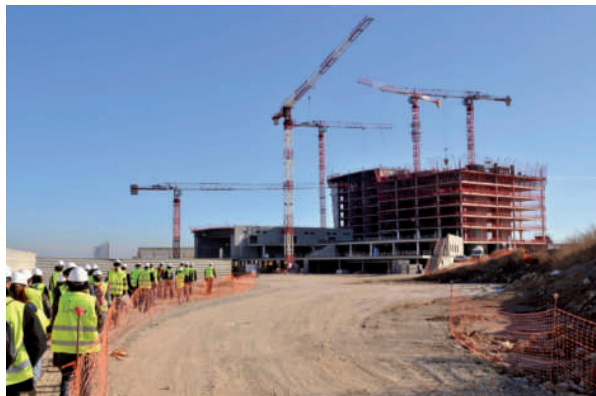
DAVANT LES OBRES DE L'HOTEL, A LA ZONA ON SE SITUARÀ EL FUTUR EDIFICI D'OFICINES TRIANGULAR, HI HA UNS GRANS MUNTOS DE TERRES QUE FAN LA FUNCIÓ DE PRECÀRREGUES
