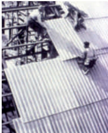
IMATGE DEL MUNTATGE DE LA PLAÇA GRANONDA D'URALITA AL PORT DE VALÈNCIA
