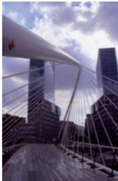
LES TORRES ISOZAKI EMMARQUEN UNA PLAÇA GRAONADA QUE DESEMBOCA AL PONT DE ZUBIZURI
