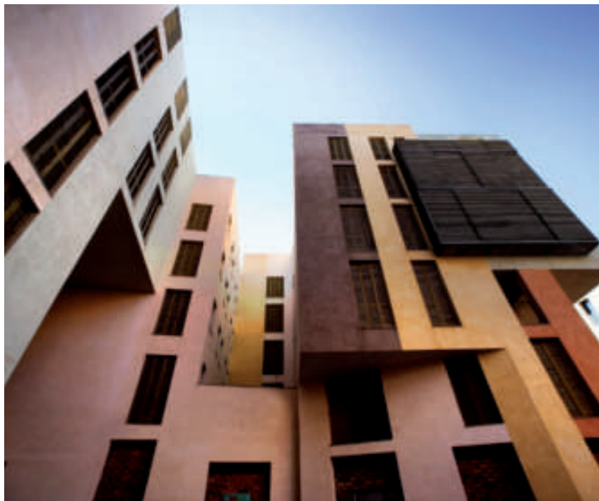
HABITATGES AL BARRI DE SANTA CATERINA. L'INFORMATIU 270
