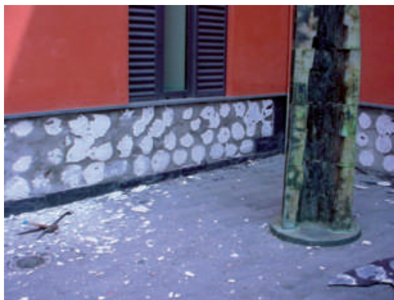
DESPRENIMENT D'APLACATS - HAN MANCAT ASSAIGS D'ADHERÈNCIA.
