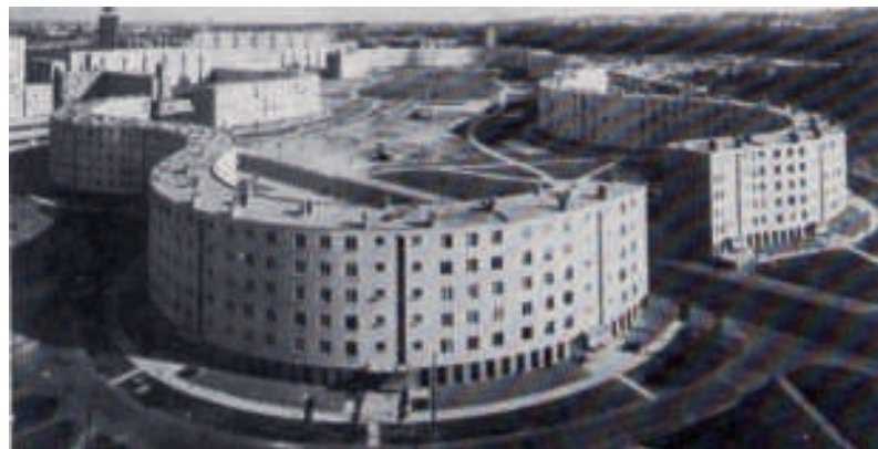
VISTA DE LA GRANDE BORNE, A FRANÇA, PROJECTAT PER EMILE AILLAUD I REALITZAT ENTRE 1966 I 1970 AMB ELEMENTS PREFABRICATS, SEGUINT EL DESPLAÇAMENT PER VIES DE LES GRUES.
