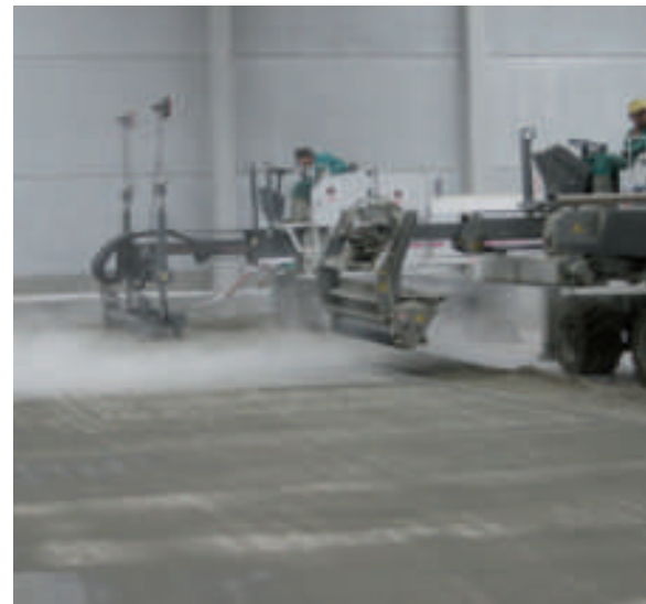
LES NOVES TECNOLOGIES PER A LA POSADA EN FORMIGÓ PERMETEN UN EQUIP D'ESTENEDORA LÀSER
