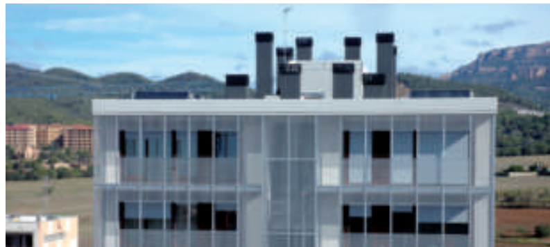
LA NOVA LLEI INCIDEIX EN LA CONSTRUCCIÓ DE NOUS HABITATGES DE PROTECCIÓ OFICIAL, COM EL QUE ES POT VEURE A LA FOTO DELS HABITATGES DE CAN ROCA II DE TERRASSA
