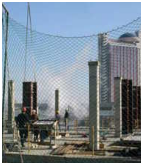
CTIVES DE FORQUES I XARXES UTILITZADES EN EL IT DE L'ESTRUCTURA. ELS TREBALLS DE FERRALLA, LOCACIÓ DE PLAQUES METÀL·LIQUES DELS PILARS S'HAN JUINES ELEVADORES EN TOT EL PROCÉS DE L'OBRA.
