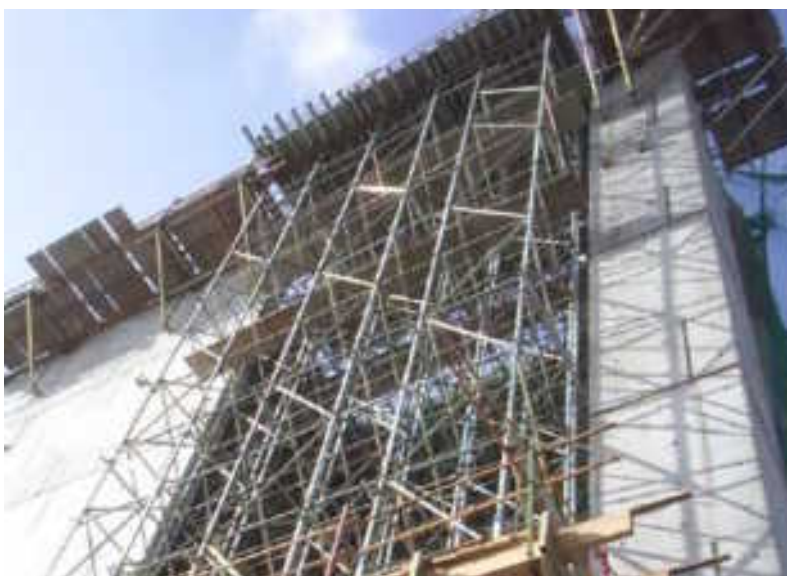
CINTRA UTILITZADA EN L'EXECUCIÓ DELS MURS DE CORONACIÓ DELS FINESTRALS DE LES FAÇANES SUD.
