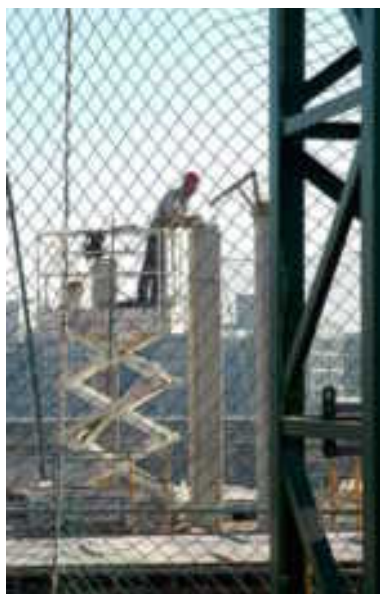
EQUIP DE FERRALLISTES PREPARANT L'ARMAT DE SOBRE EL SOSTRE DE LA GALERIA TÈCNICA DE L'EDIFICI D.
