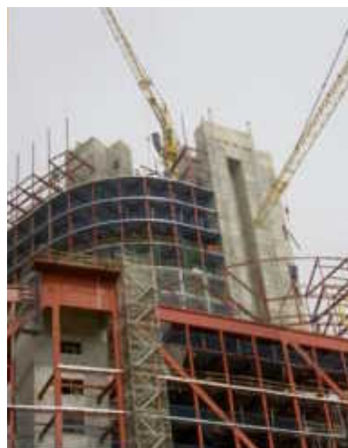
TORRE DE GAS NATURAL, PREMI A LA COORDINACIÓ DE SEGURETAT 2007
