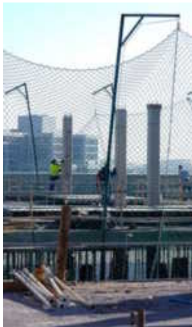
PROTECCIONS COL·LECTIVES DE FORQUES I XARXES VERTICALS EN L'EDIFICI D.
