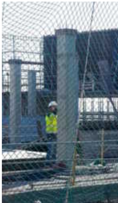
PROTECCIONS COL·LECTIVES DE FORQUES I XARXES VERTICALS EN L'EDIFICI D.
