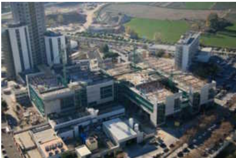
VISTA GENERAL DE L'OBRA HOSPITAL DE BELLVITGE, FAÇANES NORD DELS EDIFICIS F, G, B, C I D.
