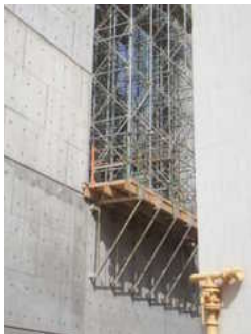
SE ESPECIAL DE CINTRA SOBRE TREPA, PER NO AFECTAR ER D'ACCÉS ÚNIC AL MORTUORI I AL MAGATZEM DE A.
