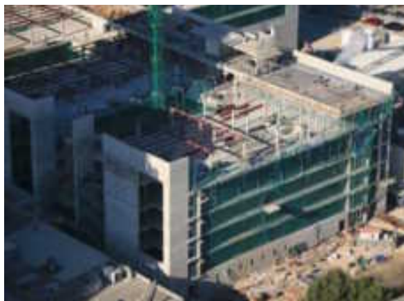
PROTECCIONS DEFINITIVES DE LA FAÇANA EST DE L'EDIFICI D AMB XARXA VERTICAL.
