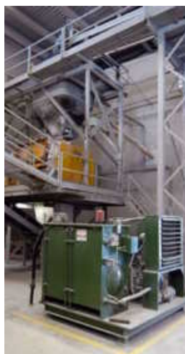
7. PASTERA ON ES BARREGEN TOTS ELS COMPONENTS DEL FORMIGÓ
