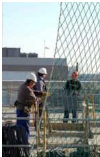
RETIRADA DE LES FORQUES UN COP ACABAT L'EDIFICI F I UNA VEGADA COL·LOCADES LES PROTECCIONS DEFINITIVES.
