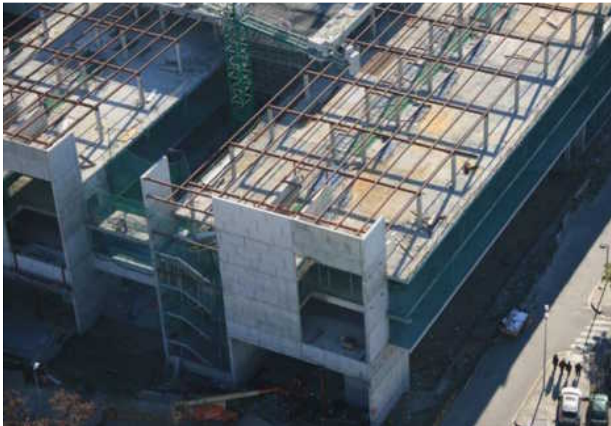
FAÇANES NORD DELS EDIFICIS F I G. ES PODEN OBSERVAR LES PROTECCIONS COL·LECTIVES DEFINITIVES (XARXES VERTICALS DE FAÇANA).
