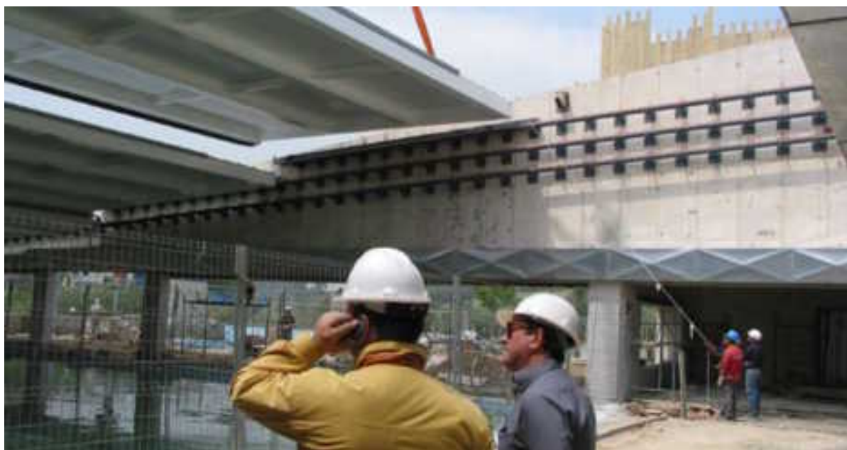
PROCÉS D'EXECUCIÓ DE LA COBERTA DE LA PISCINA MUNICIPAL DE LA ROCA DEL VALLÈS, CANDIDATURA FINALISTA DELS PREMIS CATALUNYA CONSTRUCCIÓ 07 EN LA CATEGORIA D'INNOVACIÓ
