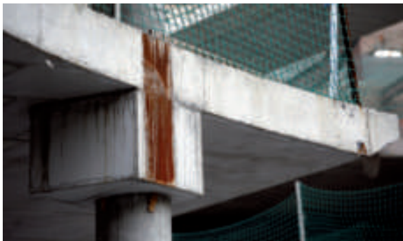
L'ARQUITECTE BASA L'ESSÈNCIA DEL PROJECTE EN L'EXPRESSIVITAT DELS DETALLS CONSTRUCTIUS. EL LLENGUATGE PERSONAL DE ROGERS ES CARACTERITZA PER MOSTRAR ELS DETALLS ESTRUCTURALS DE MANERA MOLT ACURADA
