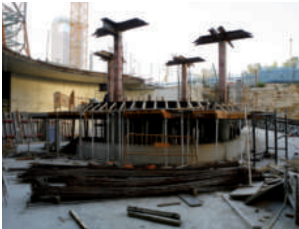
PROCÉS DE CONSTRUCCIÓ D'UNA RAMPA EN LA PART DEL CARRER DIPUTACIÓ
