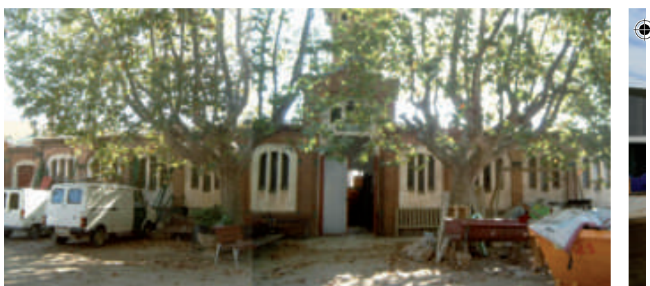
IMATGE DE L'ESTAT PREVI DE LA FAÇANA NORD. ELS ACABATS ESTAVEN MOLT MALMESOS
