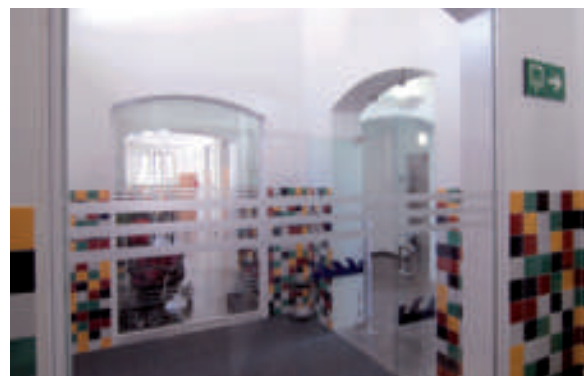
ES VA RESPECTAR LA DISTRIBUCIÓ INTERIOR ORIGINAL, PER TAL DE NO DESVIRTUAR ELS ESPAIS ORIGINALS.
