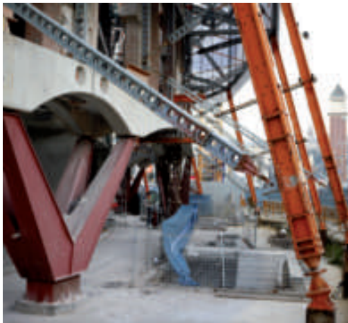
PER CONNECTAR ELS MICROPILONS A LA FAÇANA EXISTENT ES VA COL·LOCAR UNA VIGA ARC DE FORMIGÓ, AMB CLARES INTENCIONS JA "ARQUITÈCÒNIQUES"
