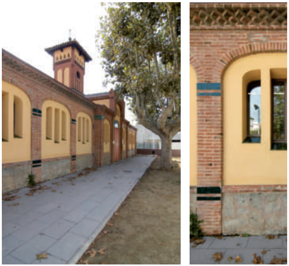
VISTES GENERALS DE LA FAÇANA NORD DESPRÉS DE LA REHABILITACIÓ. ES VA REALITZAR UN NOU ESTUC DE C
