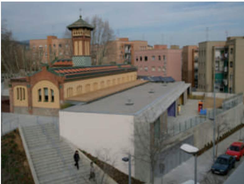
VISTA GENERAL DEL CONJUNT: LA NAU DE LA TRIPERIA REHABILITADA I LA NOVA AMPLIACIÓ
