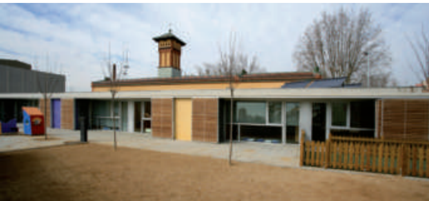
FAÇANA SUD DEL PROJECTE D'AMPLIACIÓ: UNA NOVA FESOMIA QUE S'OBRE A LA CIUTAT
