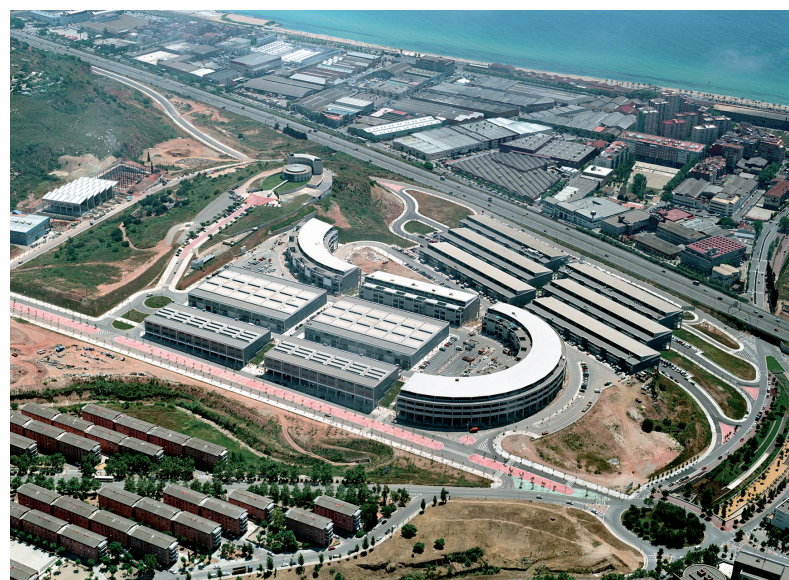
COBERTES AMB LÀMINES DE PVC
