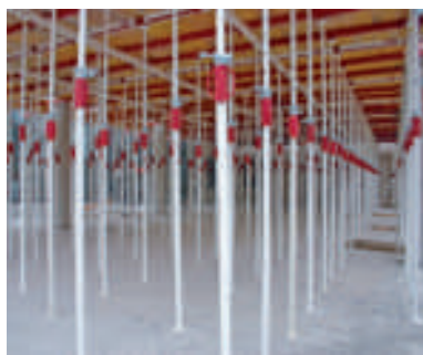
PUNTAL EUROPROP ALSINA A30 EN UNA AMPLIACIÓ D'OFICINES A MONTCADA I REIXAC
