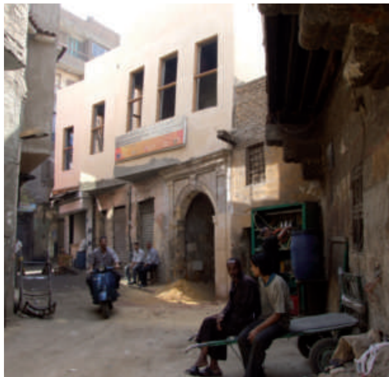
TREBALLS DE REHABILITACIÓ QUE DUU A TERME REHABIMED, AL CAIRE
