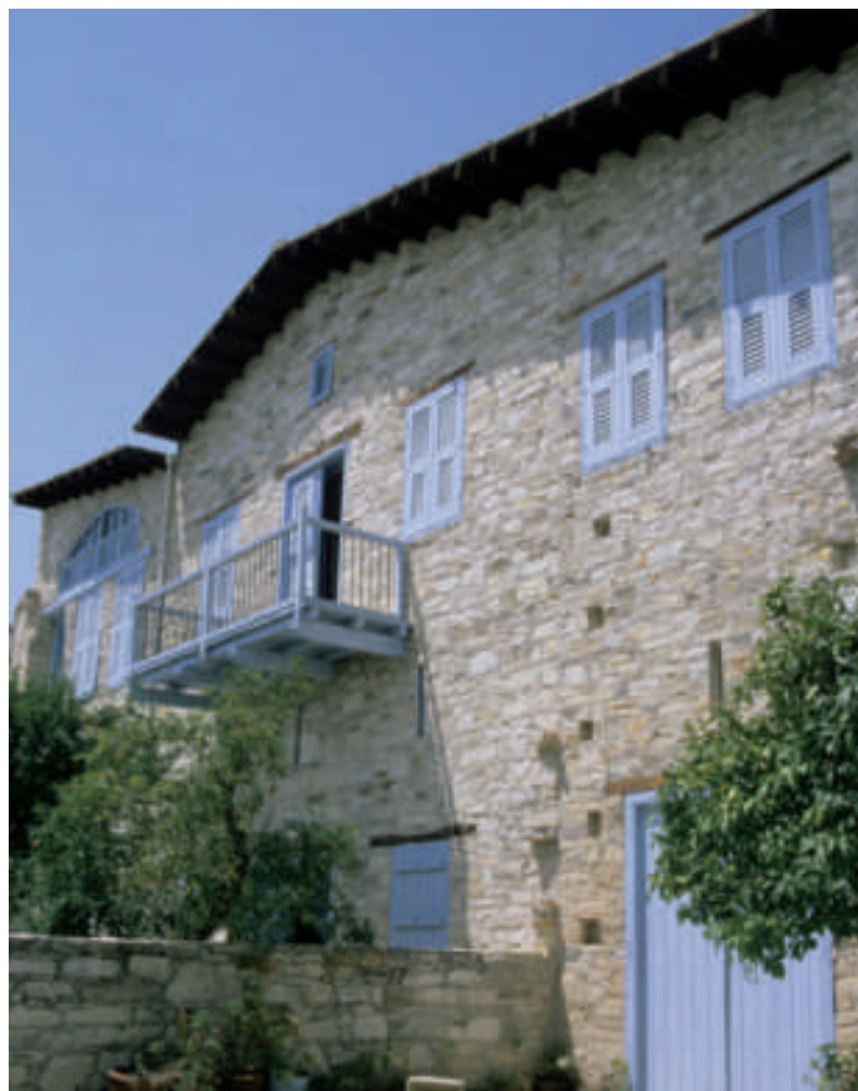
MUSEU LOCAL DE LEFKARA. LA REHABILITACIÓ FETA L'ANY 1975, A LA RECERCA DE LA RUSTICITAT D'AQUELLA ÈPOCA, VA REPICAR TOTES LES FAÇANES
