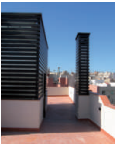
EL BADALOT I ELS ELEMENTS SORTINTS DE COBERTA S'HAN TANCAT AMB UN SISTEMA LLEUGER DE PERFILS D'ALUMINI I PLAQUES DE POLICARBONAT.
