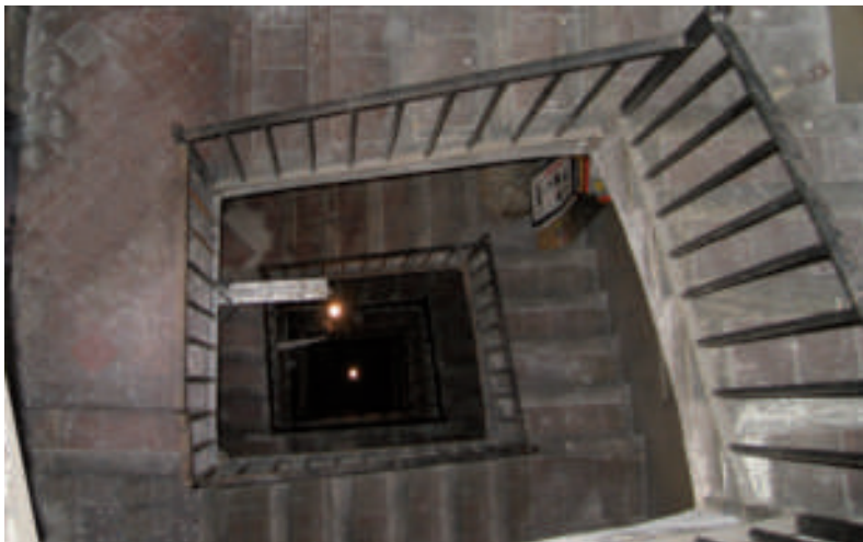
ELS NOUS REPLANS D'ESCALA PERMETEN L'ACCÉS A L'ASCENSOR I EL REGISTRE DE LES INSTAL·LACIONS
