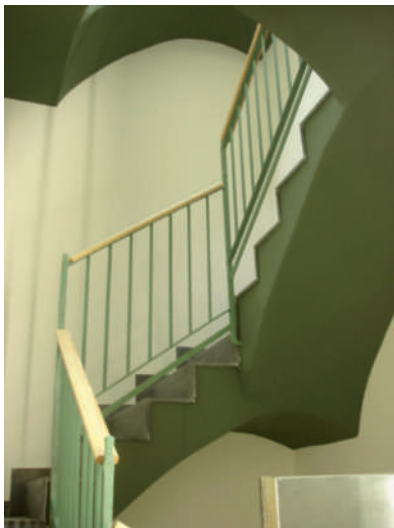
LES VOLTES D'ESCALA S'HAN REFORÇAT I S'HA REFET LA TOTALITAT DE L'ESGLAONAT
