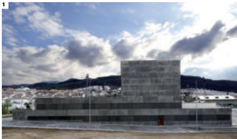
1. PREMI D'ARQUITECTURA. SEU JUDICIAL D'ANTEQUERA, MÀLAGA. LLOC: ANTEQUERA. ARQUITECTES: IGNACIO LAGUILLO I HARALD SCHÖNEGGER. ARQUITECTE TÈCNIC: ROBERTO ALÉS
