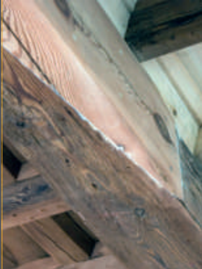
caso 2, reparación en el centro del vano
