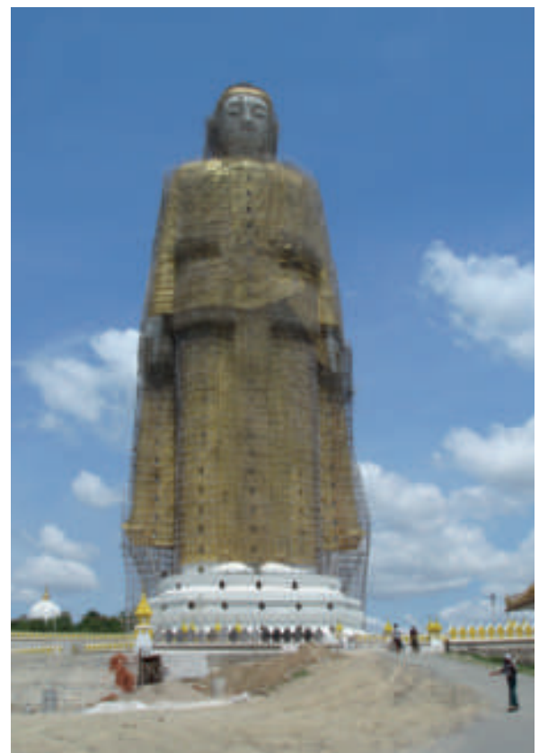
CONSTRUCCIÓ D'UN BUDA DE 115 METRES D'ALÇADA A MONYWA.
