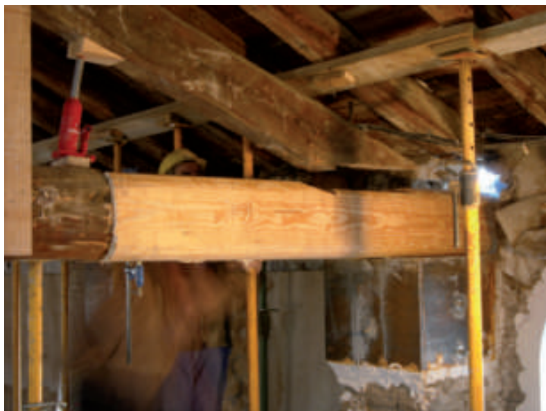
REPARACIÓ DE TIRANT DE CINTRA
