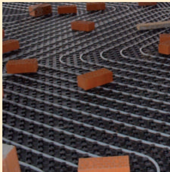
INSTAL·LACIÓ DE TERRA RADIANT.
