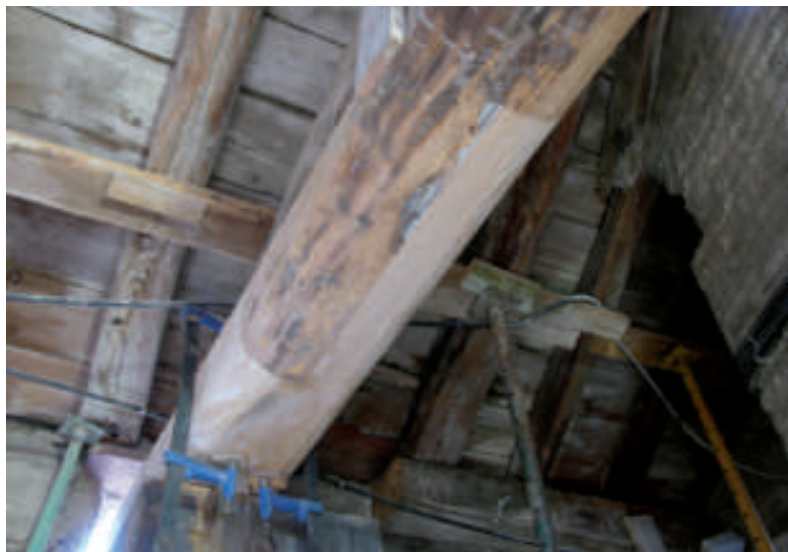
REPARACIÓ DE TIRANT DE CINTRA
