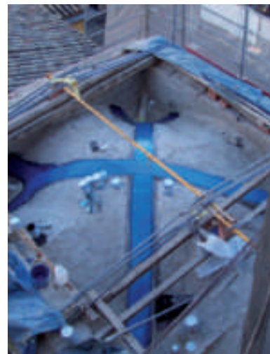
ENCERCLAT DE CÚPULES D'OBRA DE FÀBRICA AMB MATERIALS COMPOSTOS ARMATS A BASE DE FIBRES DE CARBONI
