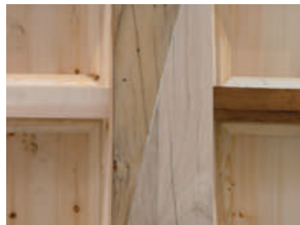
REPARACIÓ EN EL CENTRE DE LA LLUM
