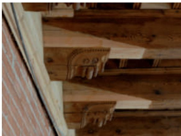
REPARACIÓ EN EL RECOLZAMENT
