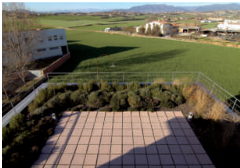
UNA DE LES COBERTES DE L'EDIFICI ÉS VERDA I APORTA ESTABILITAT TÈRMICA
