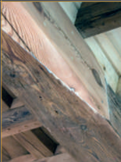
caso 2. reparación en el centro del vano
