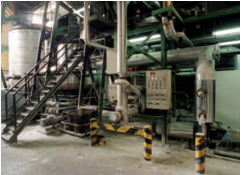
2. A L'ESQUERRA AL FONS, REACTOR DE MESCLA AMB L'SBS. EN PRIMER TERME, EL MESCLADOR DEL CARBONAT CÀLCIC
