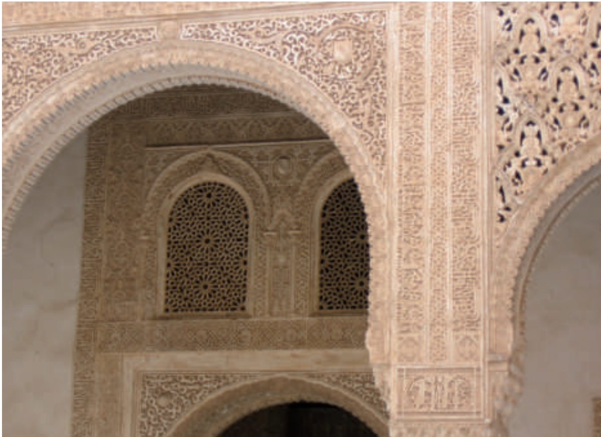
RICS I COMPLEXOS TREBALLS DECORATIUS EN ESTUC DE CALÇ O GUIX (DEPENDENT SI ÉS INTERIOR O EXTERIOR) DE LES ESTANCES REIALS DEL PALAUS NASSARITES
