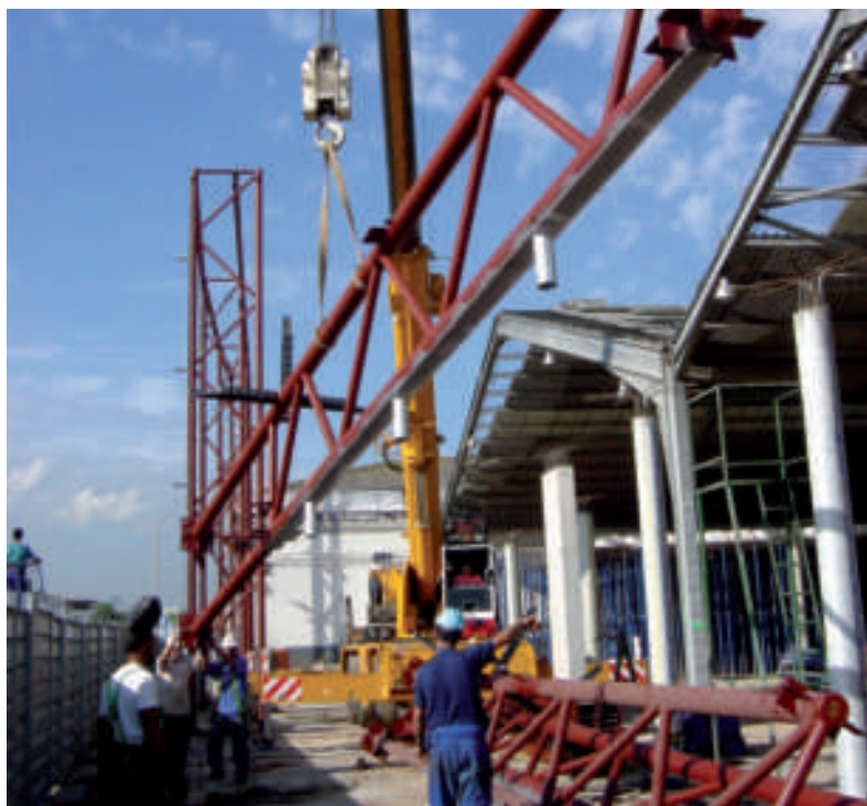
OBRES DEL NOU CONCESSIONARI BMW A SABADELL, SELECCIONADA ALS PREMIS CATALUNYA CONSTRUCCIÓ 2005, AMB JOEL VIVES COM A ARQUITECTE TÈCNIC
