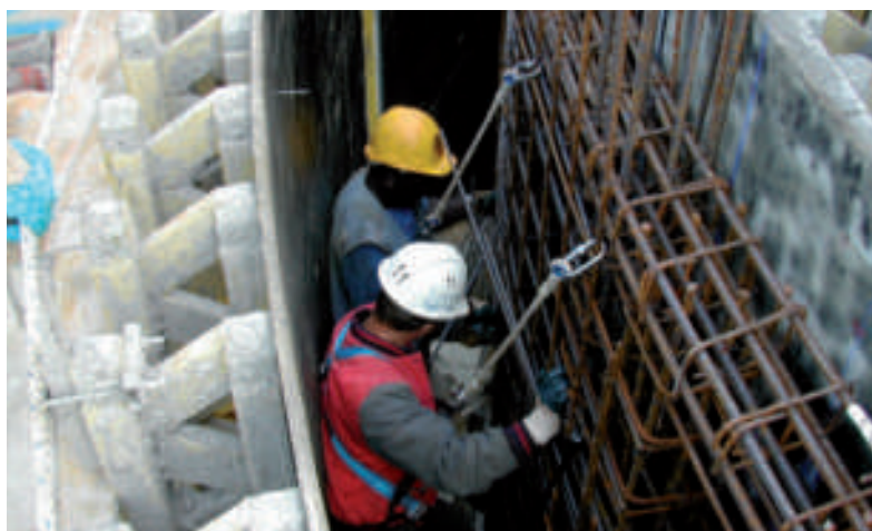
MESURES DE SEGURETAT EN ELS TREBALLS D'EXECUCIÓ DE L'ESTRUCTURA PORTANT DE LA TORRE AGBAR A BARCELONA
