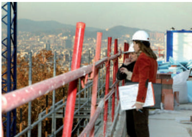
MARIA ROGER I SUSANA PAVÓN EN LA VISITA D'OBRA A L'HOTEL MIRAMAR DE BARCELONA
