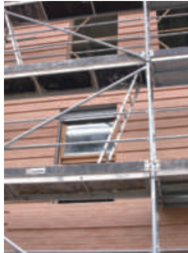
LES FINESTRES DE GUILLOTINA, DE FUSTA, ES VAN ENCARREGAR TOTALMENT ACABADES. AMB ELS VIDRES POSATS, ES VAN COL·LOCAR A LA FAÇANA QUAN JA ESTAVA ACABADA
