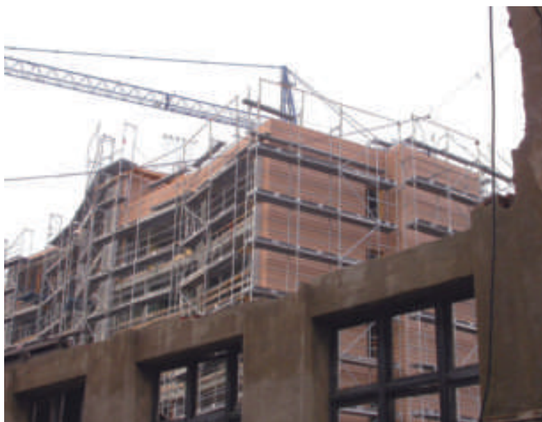
LES FAÇANES ES RESOLEN SENSE TALLAR NI UN SOL MAÓ, AMB PECES PREFABRICADES A MIDA
