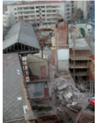
ELS FONAMENTS ES VAN FER SOBRE ROCA. A PROP DEL VAPOR ES VA FER PER PILOTATGE, ATÈS QUE ERA PERILLÓS REPICAR TAN A PROP DE L'EDIFICI
