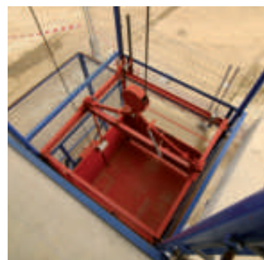
ELS ALUMNES VEUEN COM CAL INSTAL·LAR EL MUNTACÀRREGUES DE PLATAFORMA, AMB ELS DIFERENTS DISPOSITIUS DE SEGURETAT
