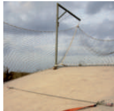
LÍNIA DE VIDA DESPLEGADA: GANXOS AMB PESTELL DE SEGURETAT A CADA EXTREM I CADELL PER AL TESATGE DE LA LÍNIA
