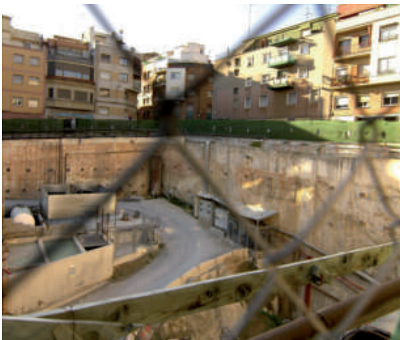
ENTRADA A LES OBRES DEL METRO A LA PLAÇA DE PASTRANA
