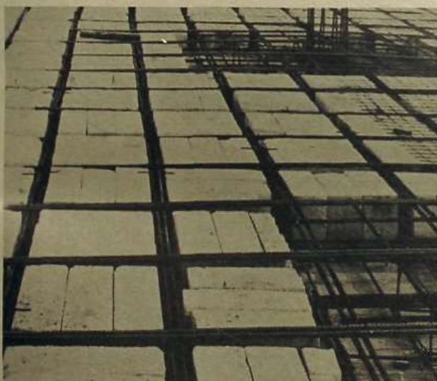
5 Entrevigado formado por piezas de hormigón ligero
