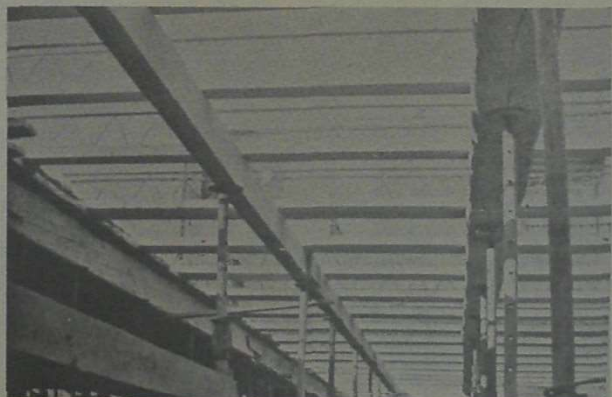
42 El apuntamiento de este tipo de vigueta debe hacerse cada 1,5 m debido a la poca resistencia inicial
