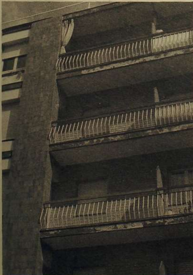
Muro de piezas prefabricadas de hormigón sobre una perfilera de acero.
