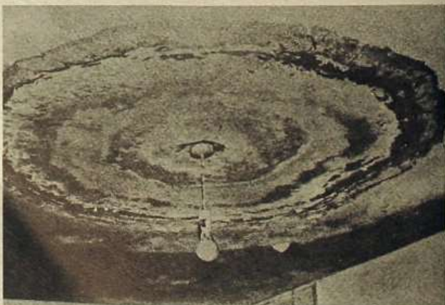
33 La penetración de agua o las condensaciones son generalmente el resultado de incompatibilidades entre subsistemas
