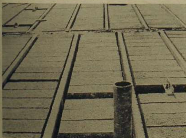
6 Entrevigado realizado con bovedillas prefabricadas de hormigón
