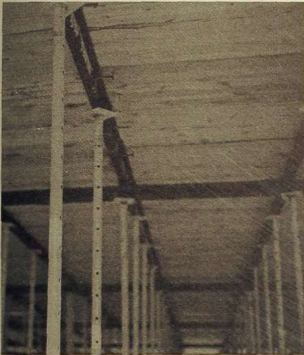
13 Puntales metálicos para encofrar fondos. Pueden utilizarse en una amplia gama de luces entre pisos
