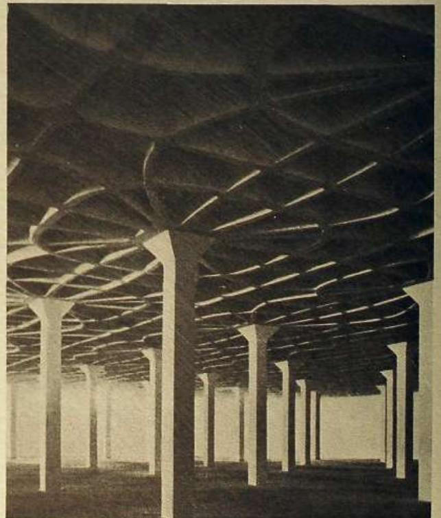
25 Vista del forjado reticular utilizado en el edificio citado anteriormente
