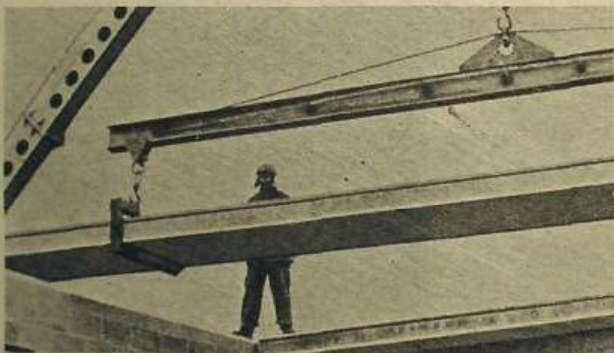
15 Es necesaria la utilización de grúa y material de suspensión adecuado, para la manipulación de las placas
