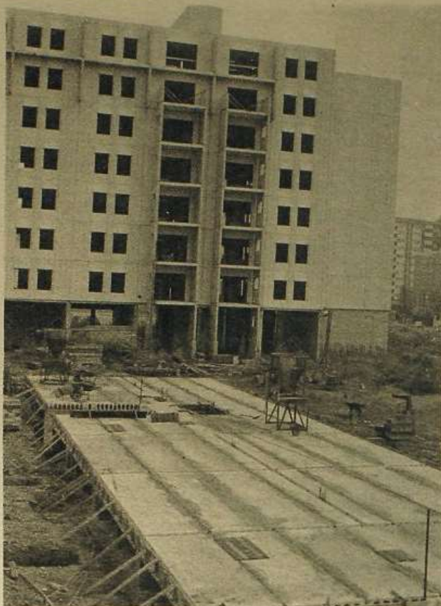
9 Forjado realizado con losas autoportantes prefabricadas. Conjunto de viviendas en Cerdanyola
