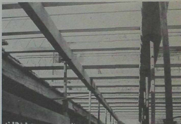
39 Las semiviguetas requieren una o más filas de puntales.
