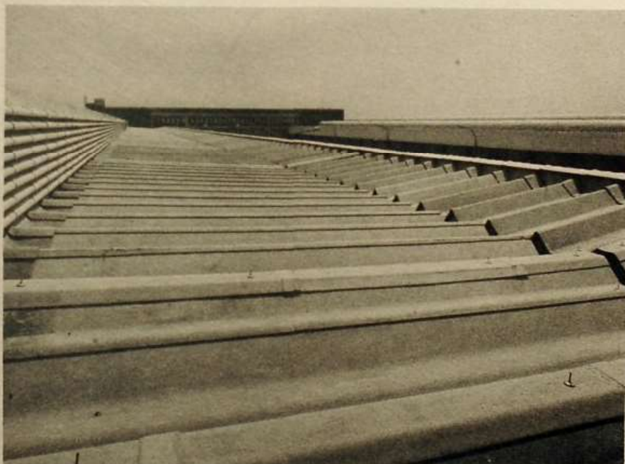
CUBIERTA CON PLACA CANALONDA
