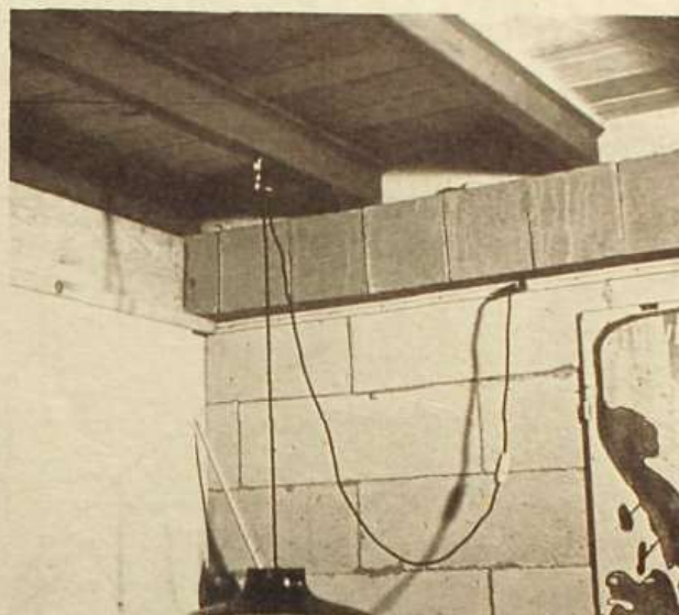
17 Forjado de perfiles laminados en frío y tablero de madera. Es evidente la facilidad de modificación y sustitución.
