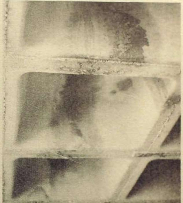
19 La junta de hormigonado anula la estanqueidad de la placa nervada vertida en obra
