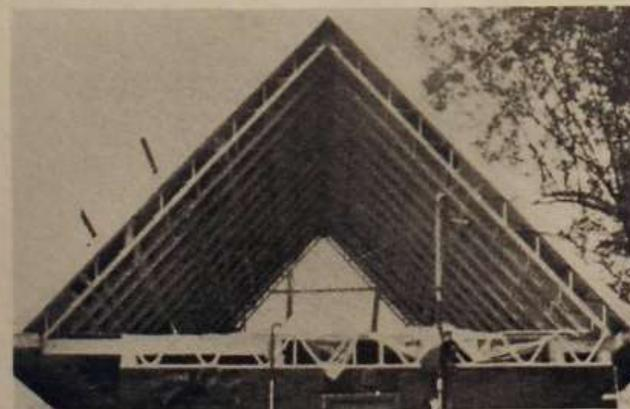
Arriba, portadas de sendos catálogos de información al usuario editadas por el estado francés. Centro, dos muestras de nuevos sistemas constructivos para paredes con aislante incorporado. Abajo, vista de cubierta a base de viga de madera con celosía de chapa galvanizada.
