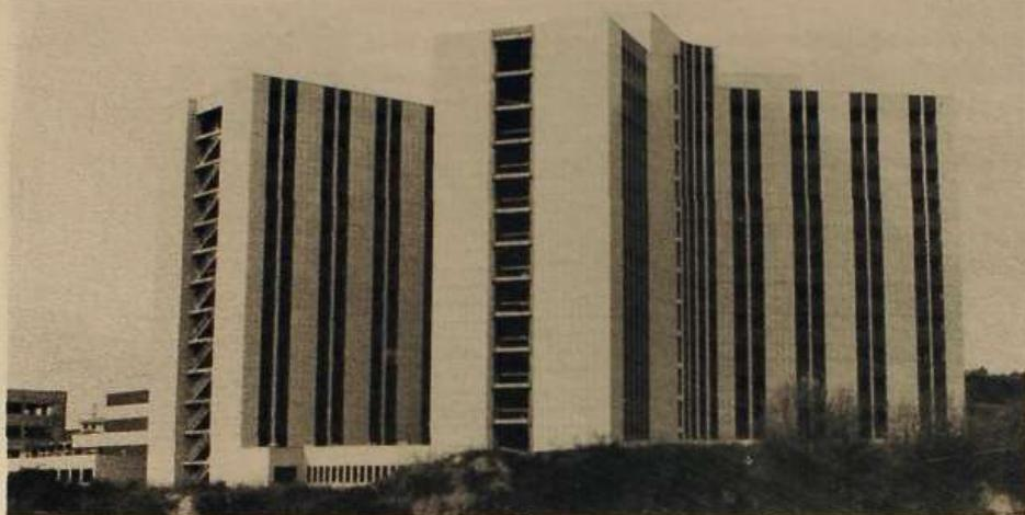
alusiones al neogótico inglés u holandés. Estructuralmente, los muros exteriores actúan como paredes de carga que soportan las losas de hormigón armado del forjado, en perfecto estado de conservación.
