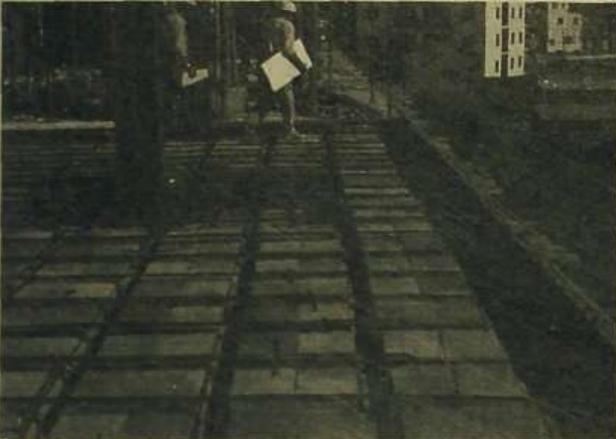
1 La parte resistente constituye el elemento primario del forjado
