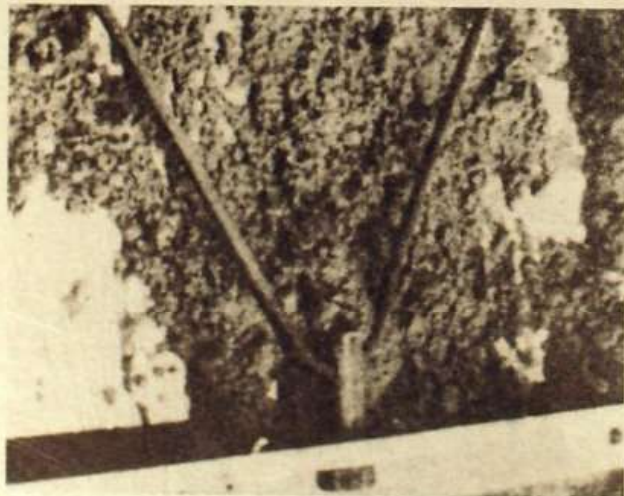
1 Dispuestos en elementos prefabricados, los manguitos permiten resolver múltiples problemas de fijación.
