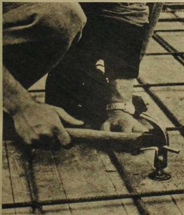
4 La colocación del anclaje se realiza durante el encofrado
