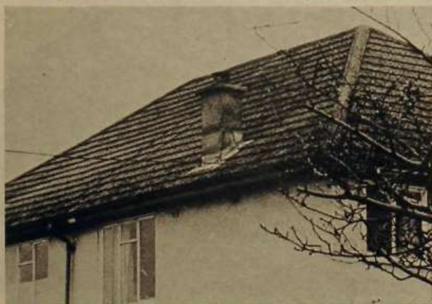
Cubiertas planas e inclinadas de uno de los grupos de viviendas cuyo coste de mantenimiento y reparación ha sido analizado por la BRE.
