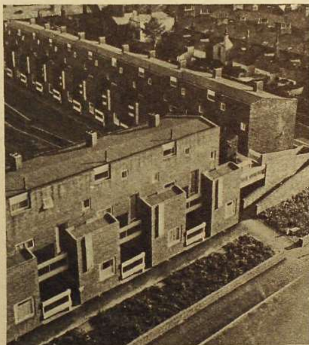
23 El diseño de fachadas prácticamente ciegas no supone una mejora en el aislamiento acústico total.
