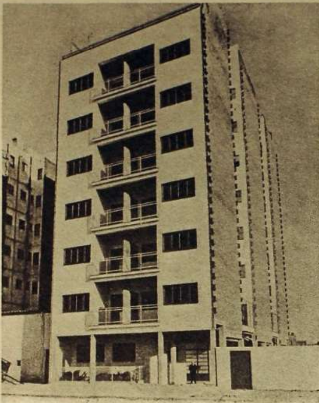
19 La proporción entre las partes fijas y practicables de un cerramiento, determina su comportamiento frente al ruido aéreo.
