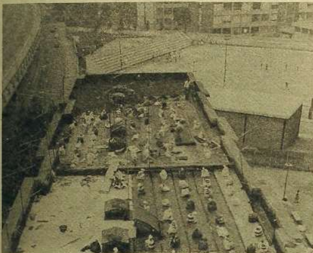
6 Aplicación del aislante en una cubierta no transitable.
