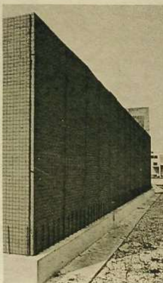
3 a 8. Proceso de construcción, con paneles de poliuretano, armados para el posterior proyectado de mortero que lo convertirá en un muro sandwich.
