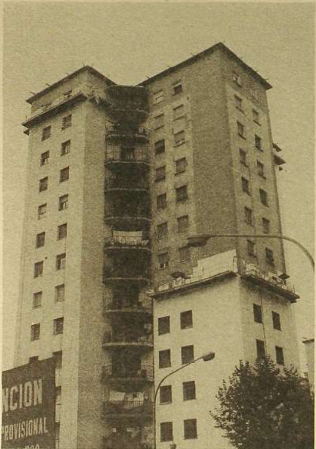
11 Colocación de las placas de aislante. En la parte superior izquierda, puede verse el aspecto final una vez pintado.
