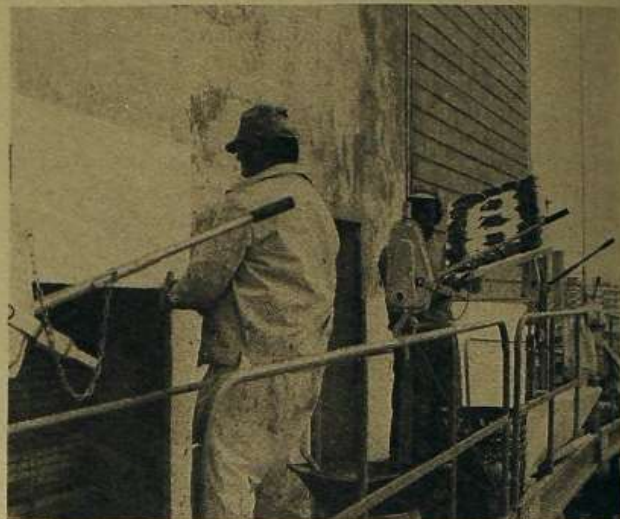
12 Colocación del aislante en un hueco de ventana.
