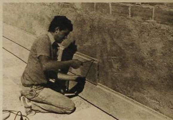
Colocación con tornillos, tacos y separadores
