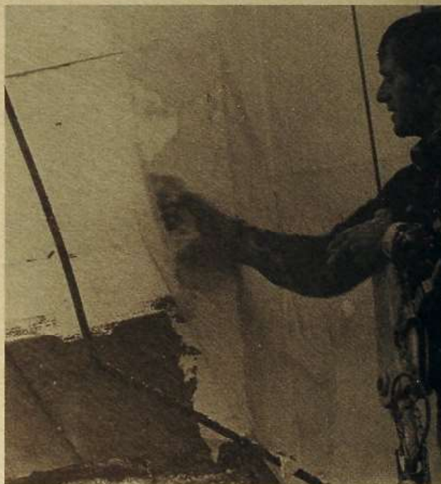
11 Antes de fraguar la primera capa de adhesivo, se coloca la armadura, solapando las tiras de tejido unos 10 cm.
