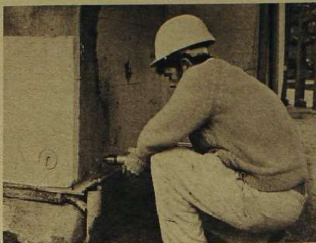
8 Preparación del soporte para la colocación de una fijación de tipo mecánico.
