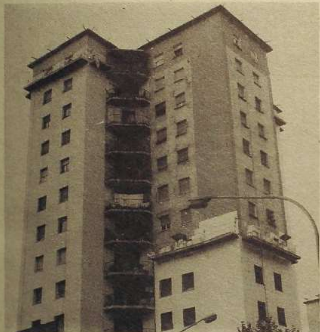
18 Una importante ventaja de este sistema es el permitir su colocación sin necesidad de desalojar el edificio.
