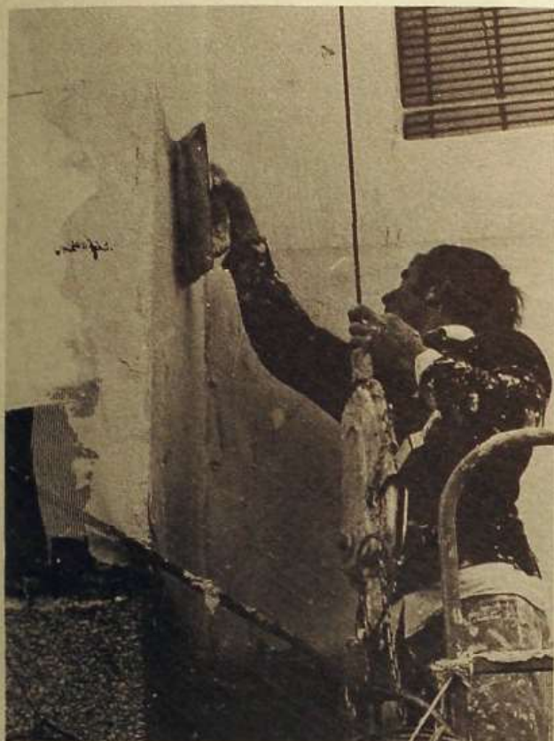
12 Una vez colocada la armadura se extiende sobre ella la segunda capa de adhesivo. Su aspecto final es liso y plano.
