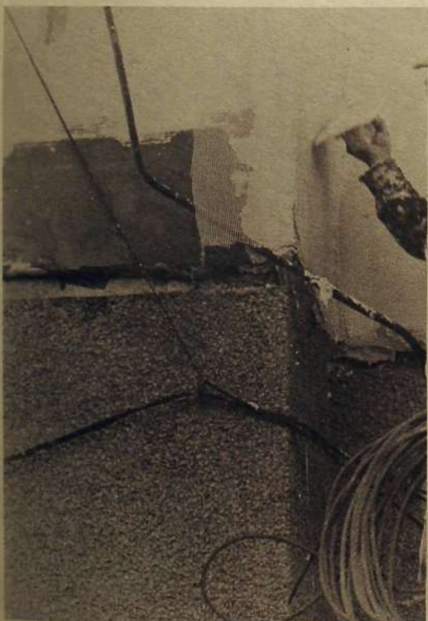
13 Colocación de la capa final de acabado.
