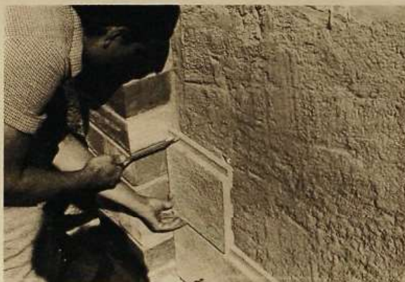
Colocación con tornillos, tacos y separadores
