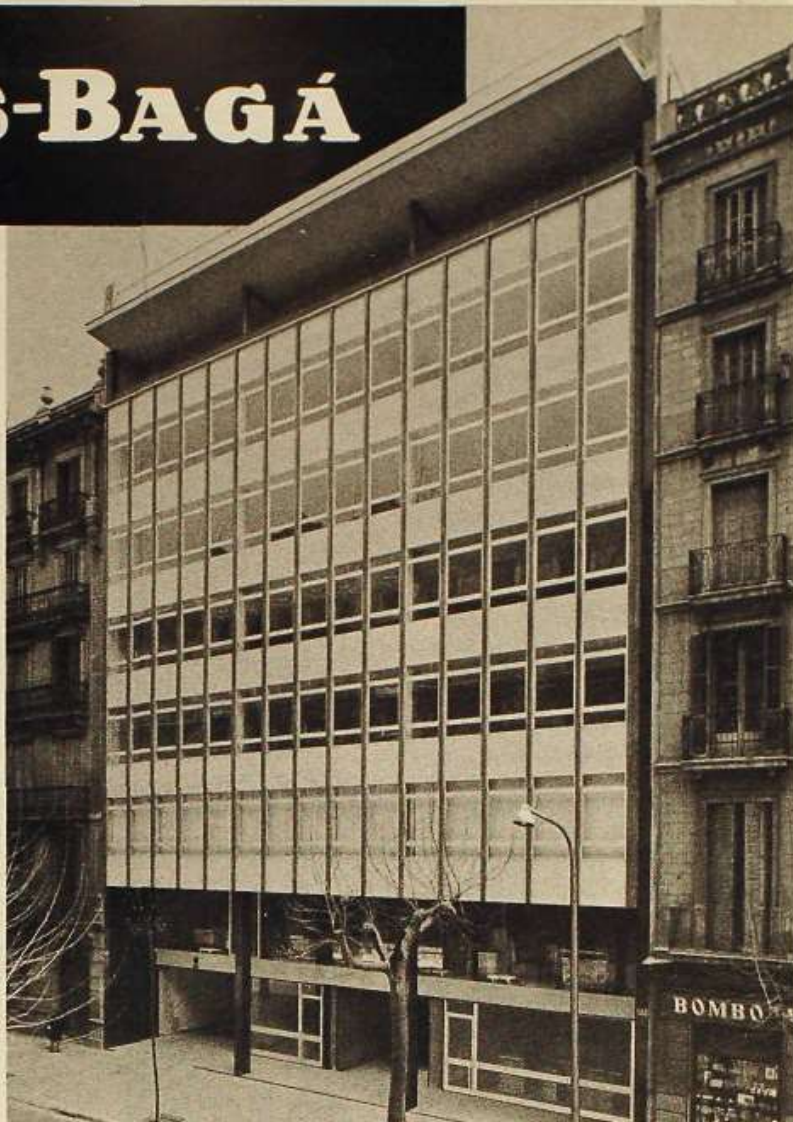
Edificio Mas Bagá - BARCELONA
