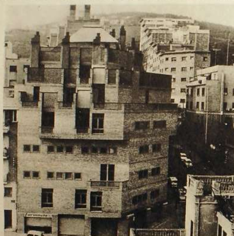
Edificio de viviendas en Barcelona
