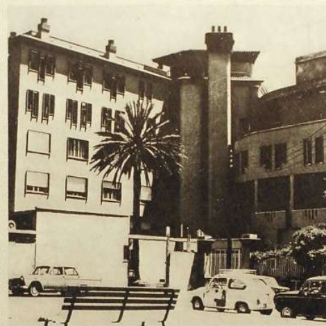
Ampliación de la Clínica Corachán en Barcelona
