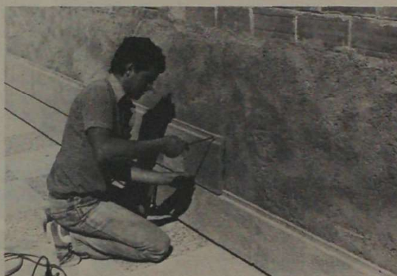
Colocación con tornillos, tacos y separadores
