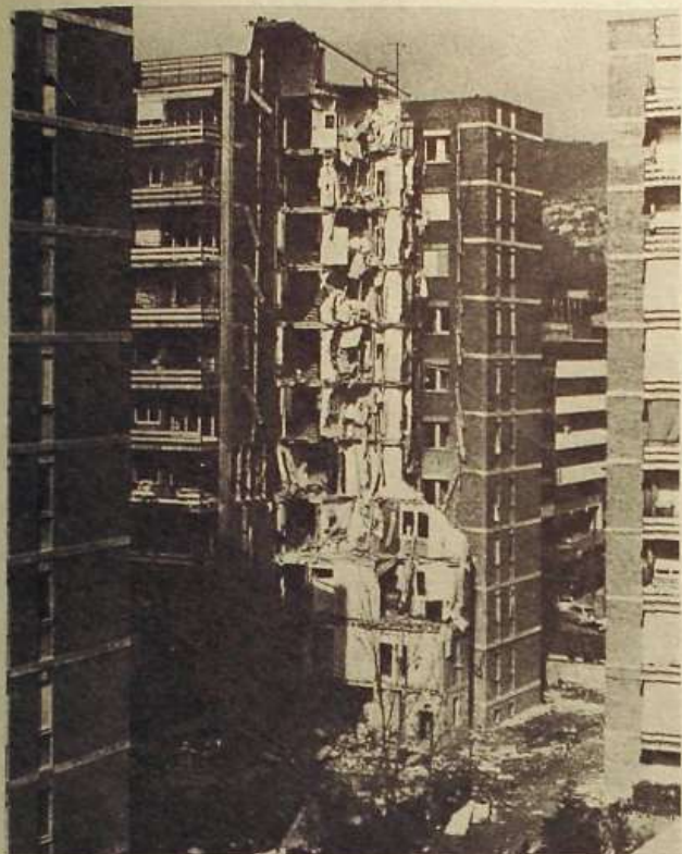
8 Colapso que ha entrañado la caída de un ala del edificio.
