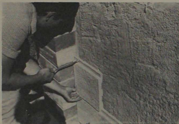
Colocación con tornillos, tacos y separadores
