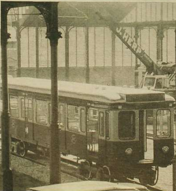
Un aspecto del montaje de la instalación central de la exposición «Trens i Estacions» en el restaurado recinto de «El Born», hasta hace pocos años Mercado Central de Barcelona.
