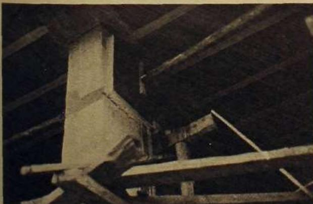
*La falta de armadura a flexión y cortante motivó la colocación de platabandas de acero encoladas a las caras inferior y laterales de la jácena.*
