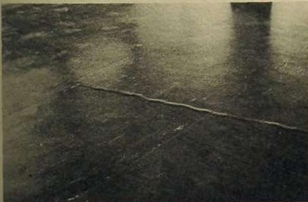
8 Arrugas en los pavimentos delgados debidos a movimientos por humedad de la capa de compresión de base.
