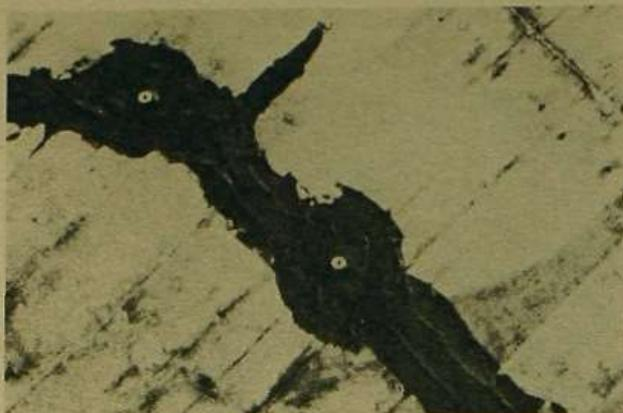
*Grieta en la que se han colocado boquillas para el posterior relleno con resina.*
