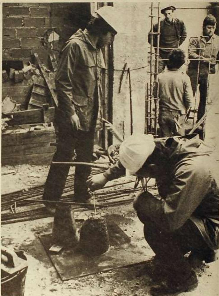
Toma de probetas de hormigón en obra.
