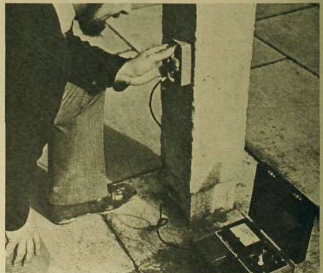
2 Medidor de recubrimientos. Ensayo no destructivo para averiguar el espesor de hormigón que tienen las armaduras.
