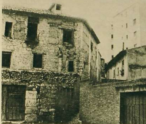
Vista parcial del edificio
