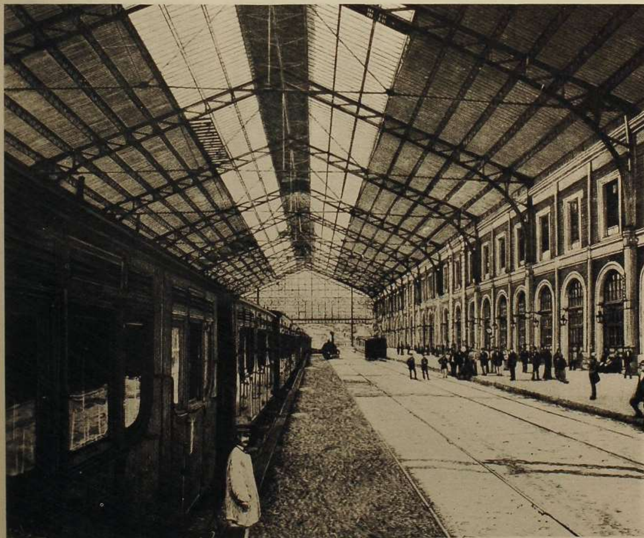
27. Cubierta de la Estación del Norte de Madrid proyectada por Mercier y terminada en 1881.
