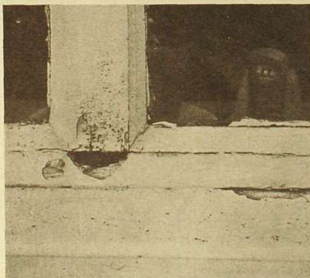
8, 9, 10 Pudrición de la madera en diferentes lugares de las ventanas.
