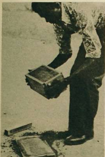
De BRU DATA SHEET (fichas técnicas del BRU). Desencofrado de un bloque.
