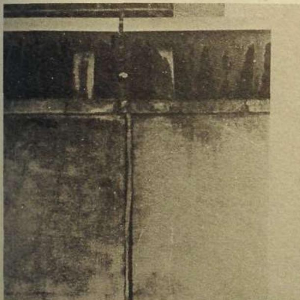
1 Con frecuencia los diseñadores no son realistas en la apreciación de las masillas. La masilla sellante de la junta del parapeto debajo de la albardilla ha perdido adherencia y se ha despegado; la separación que queda entre la masilla y los lados de la junta indica el movimiento producido.
