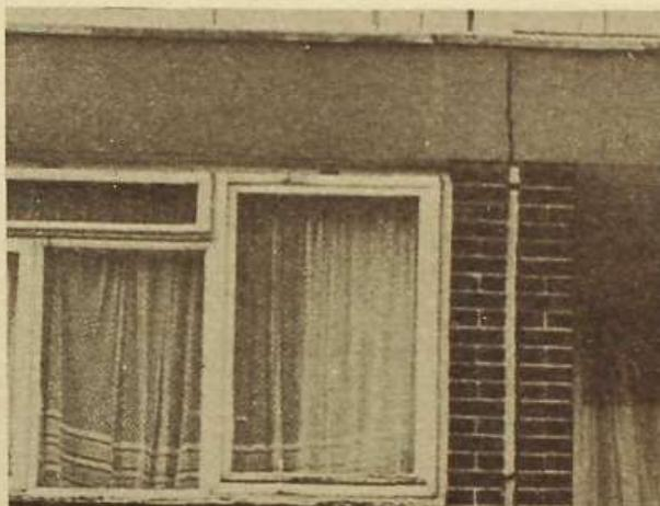
4 Pérdida de adherencia y agrietamiento del sellante. Nótese también la grieta que se produce en el dintel encima de la junta en el muro de ladrillo, por no haberse previsto junta de dilatación.
