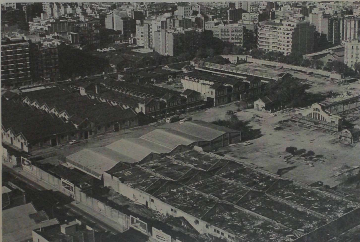
Vista general de la demolición del Matadero de Barcelona.
