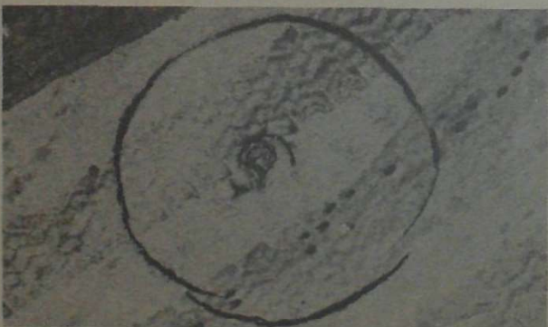
4, 5 Grietas pequeñas en el asfalto, por pérdida de elementos volátiles. Se diferencian del cuarteamiento superficial en que la grieta atraviesa toda la profundidad de la membrana impermeable hasta llegar a la base.
