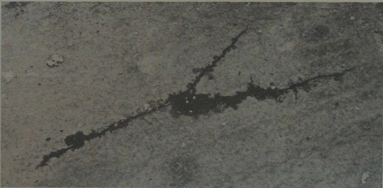
4, 5 Grietas pequeñas en el asfalto, por pérdida de elementos volátiles. Se diferencian del cuarteamiento superficial en que la grieta atraviesa toda la profundidad de la membrana impermeable hasta llegar a la base.
