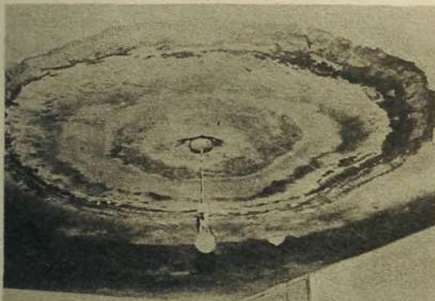
1 Penetración del agua de lluvia a través de la losa de cubierta por el orificio de la instalación eléctrica
