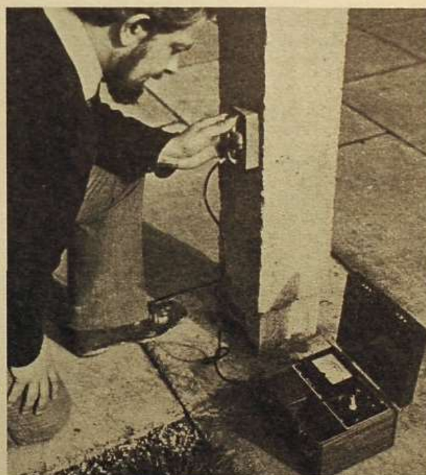
12 Medidor de recubrimientos, ensayo aproximado no destructivo sobre el espesor de hormigón que recubre las armaduras.
