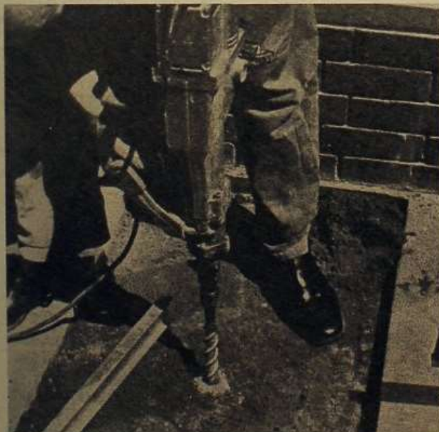
10 Utilización de una taladradora mecánica para tomar muestras
