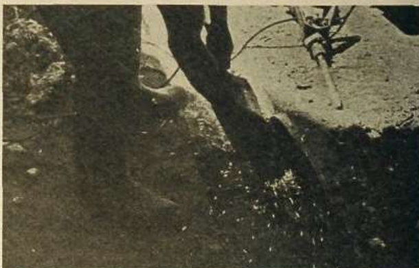
9, 10 Utilización de una sierra de carborundum para cortar una losa de hormigón armado, 9 y para cortar las armaduras de acero 10.
