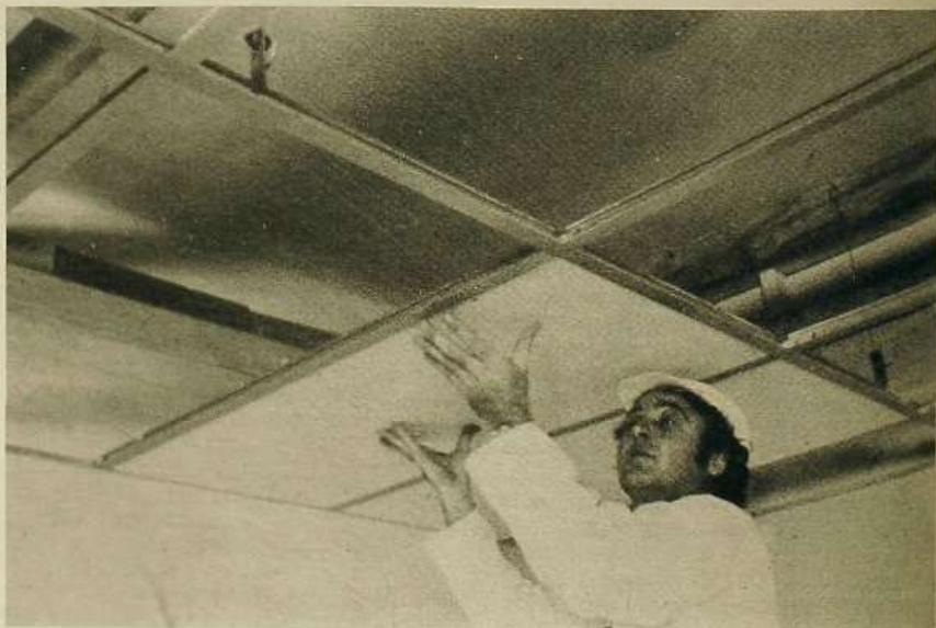
Figura 10. Perfilera vista. Las placas encajan en ella. El aspecto final es parecido al de cualquier techo de placas, común en el mercado.
