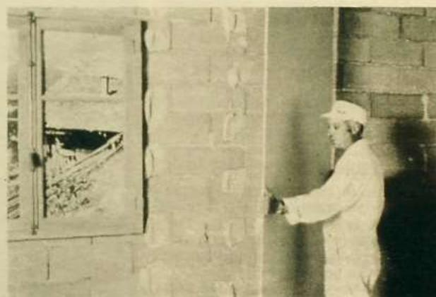
Figura 7. Colocación de la misma placa de doblado, por un simple sistema de pelliadas.
