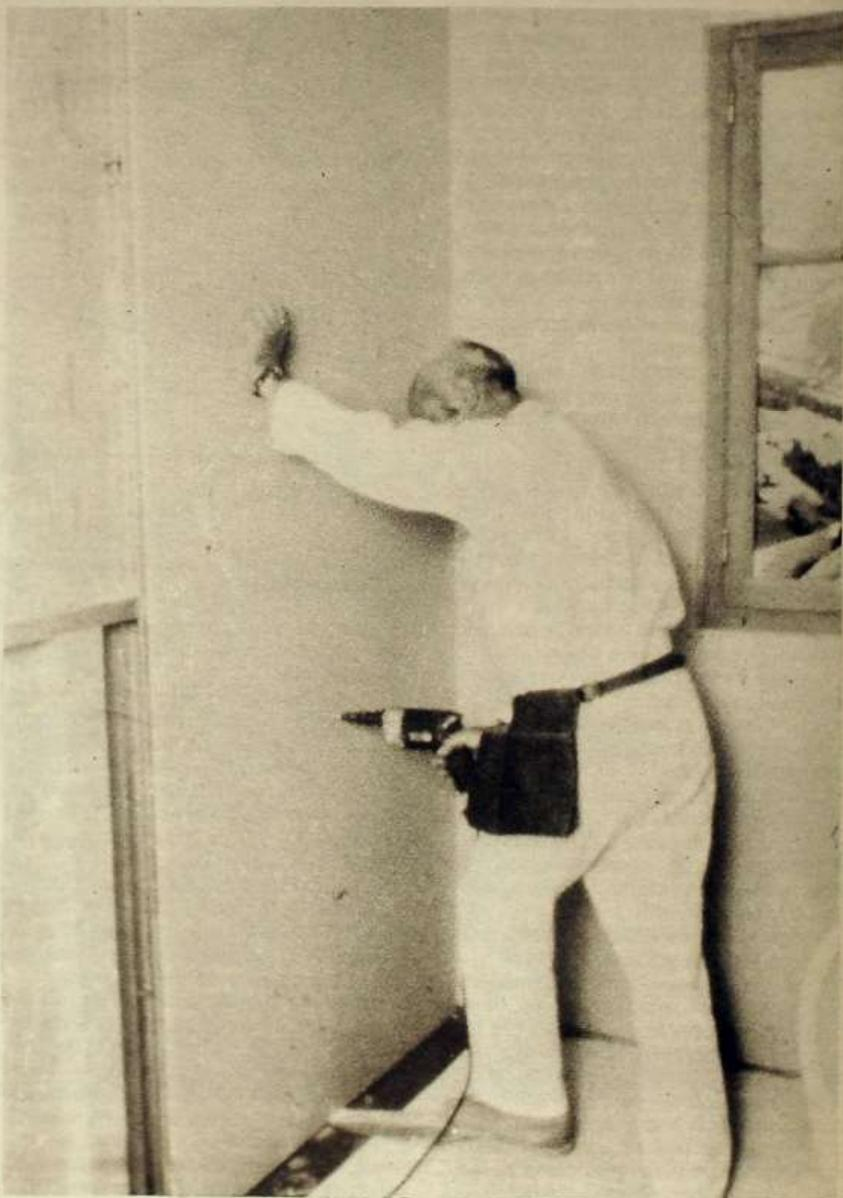
Figura 4. Tabique simple. El entramado metálico y las dos placas, suponen un espesor mínimo de 72 mm.
