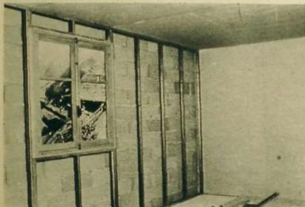
Figura 6. Entramado metálico para la colocación de una placa de doblado, en un muro exterior.
